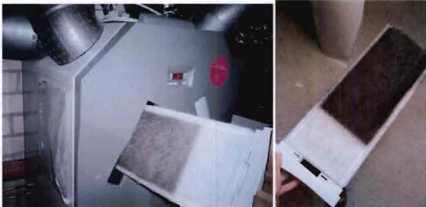
afbeelding 30: foto's van de vervuilde filters in het toevoergedeelte van de WTW. Het filter op de rechtse foto heeft 100 dagen van 24 draaiuren langer gefunctioneerd, waarbij de WTW in stand 2 heeft gestaan.
