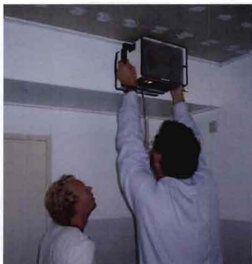
afbeelding 27: foto van het meten van het luchtdebiet per rooster met een flowfinder
