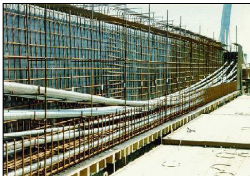
Figuur 2.6 Nagerekte voorgespanssen constructie in uitvoering
