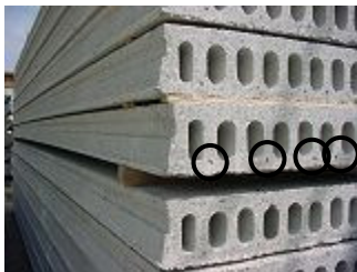
Figuur 2.5 Voorbeeld kanaalplaatvloer
