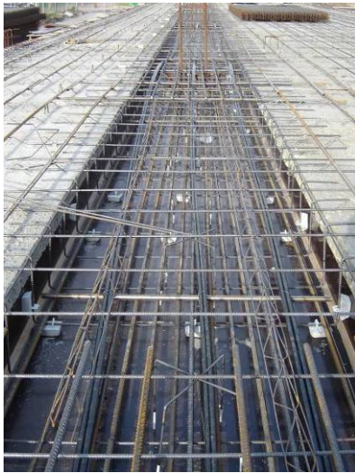
Figuur 4.10 VZA toepassing in vloerconstructies
