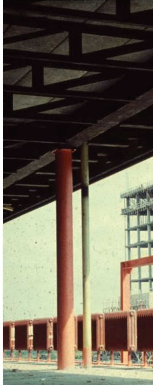
Afbeelding rechts [27] : Laagbouwconstructie in aanbouw
