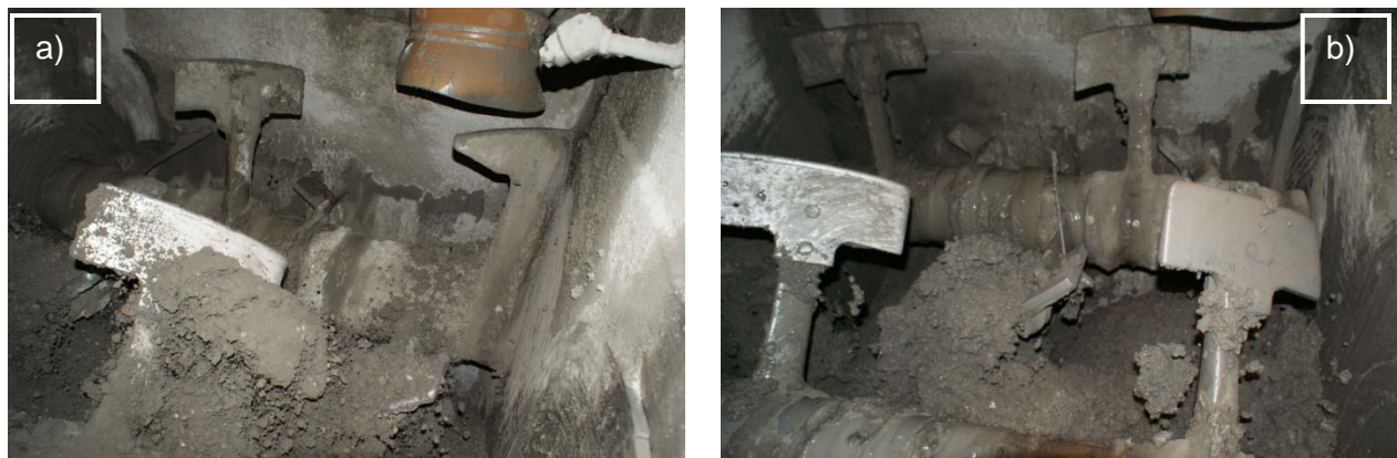
Figure 6-4; a-b) inside mixer Kijlstra Betonmortel B.V.
