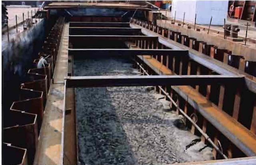
Afbeelding 2.6.6.1: Bouwkuip met stalen damwanden die onderling zijn gestempeld,
