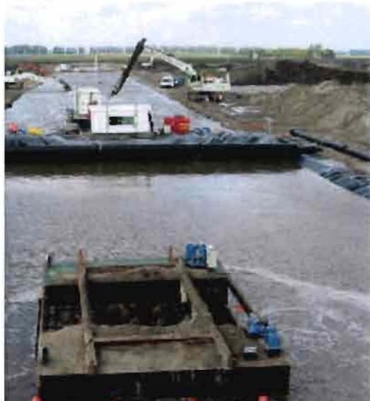
Afbeelding 2.4.3: het afzinken van een folie door middel van overdruk [11]
