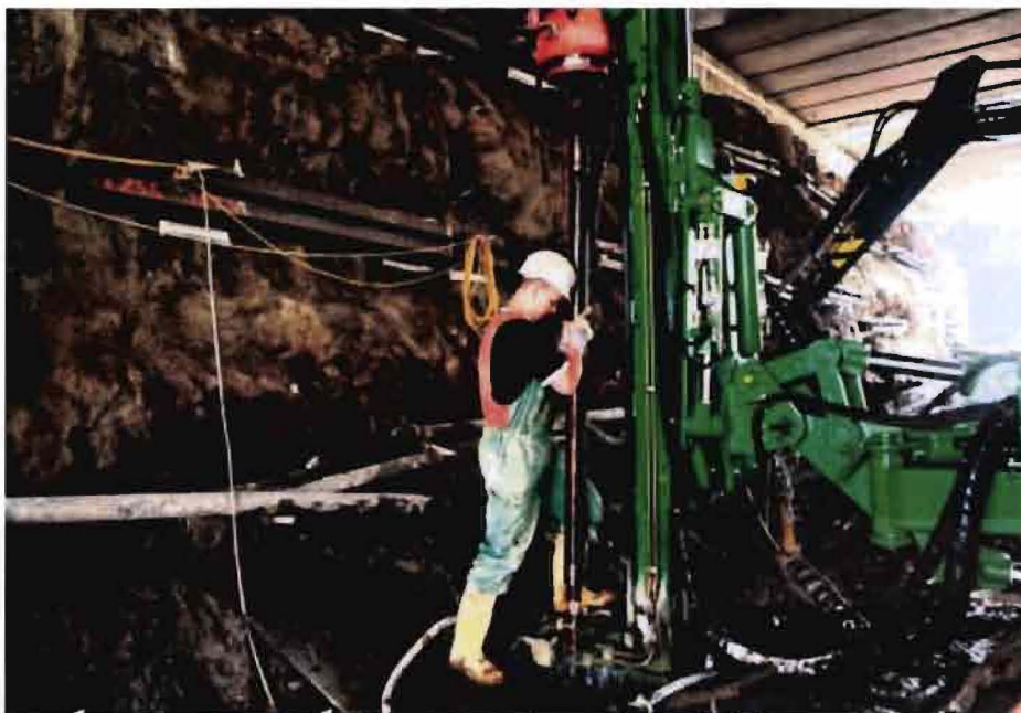
Afbeelding 2.5.11.1: Afbeelding waar een jetgroutkolom wordt gemaakt. [30]
