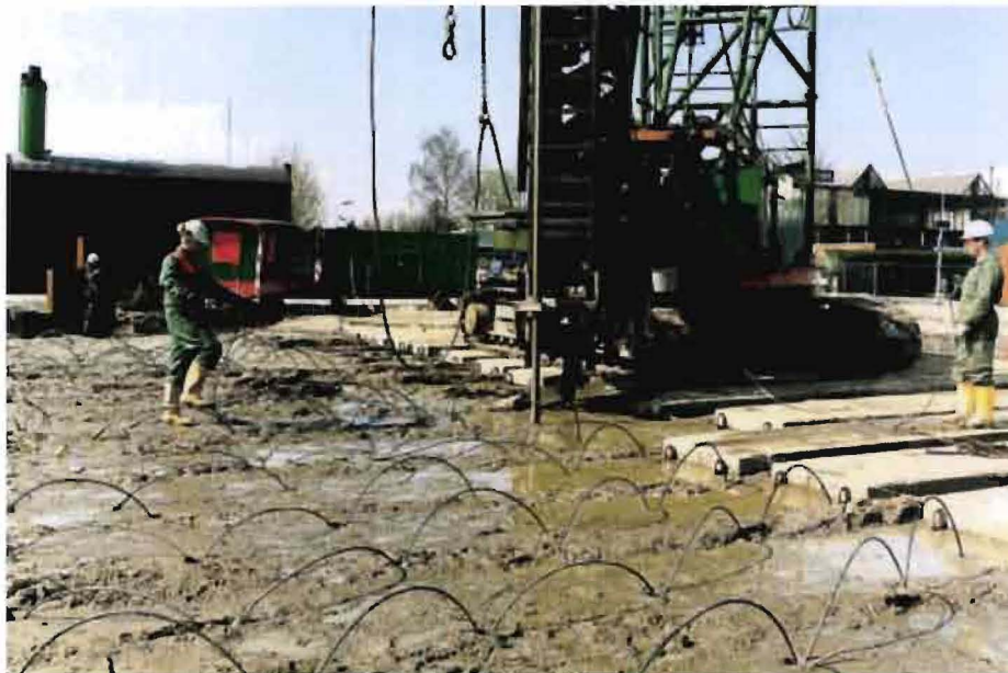
Abbeelding 2.5.12.1: Het uitvoeren van bodeminjectie. [32]
