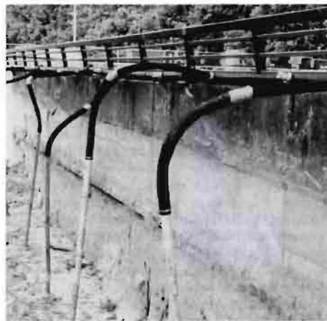
Abbeelding 2.2.1.1: Links een afbeelding en het principe van zwaartekrachtbemaling, rechts van vacuümbemaling. [7]
