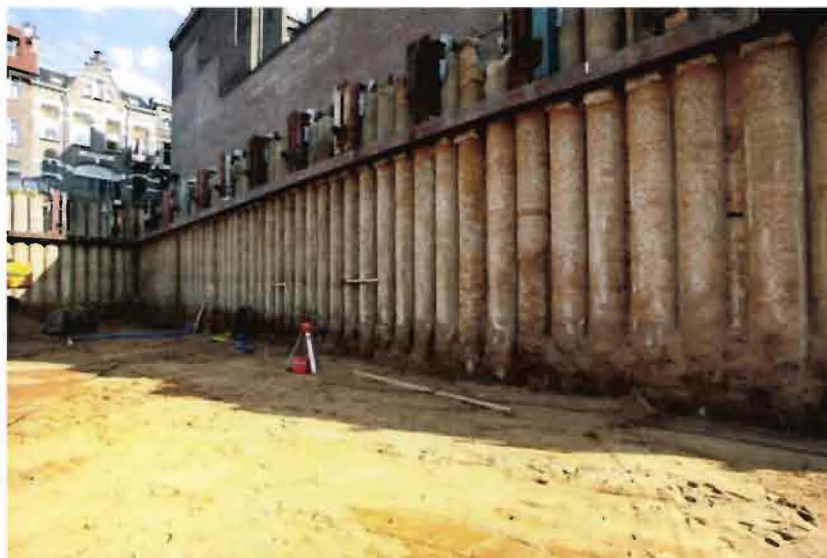
Afbeelding 2.5.4.1: Bouwkuip met een palenwand [20]
