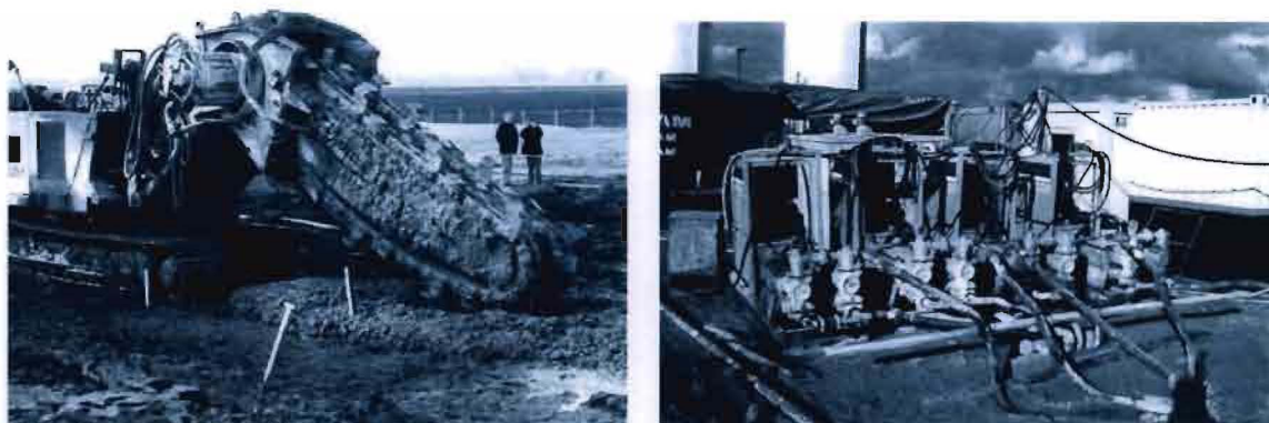
Afbeelding 2.5.9.1: het veldvoertuig en de ondersteunende apparatuur voor frees meng injectie. [29]
