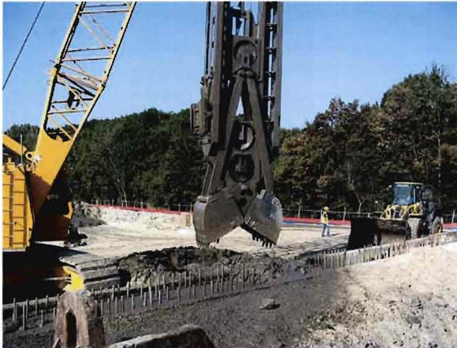
Afbeelding 2.5.5.1: Afbeelding van het vervaardigen van een diepwand. [23]
