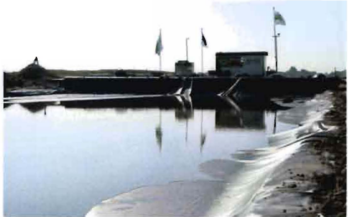
Abbeelding 2.4.1: Bouwput waar een waterkerend folie is aangebracht. (bron: www.foliebouw.nl )
