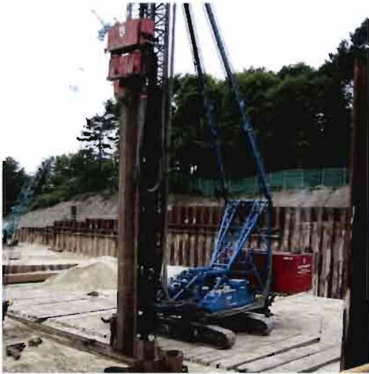
Afbeelding 2.5.1.2: Inbrengen van een stalen damwandelement [13]
