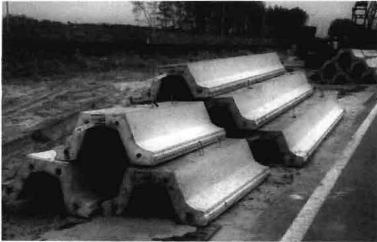
Afbeelding 2.5.2.1: prefab betonnen damwandelementen
