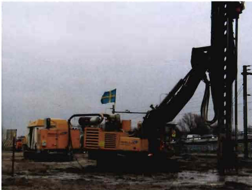
Abbeelding 2.5.8.1: Uitvoering van kalk-cementkolommen.
