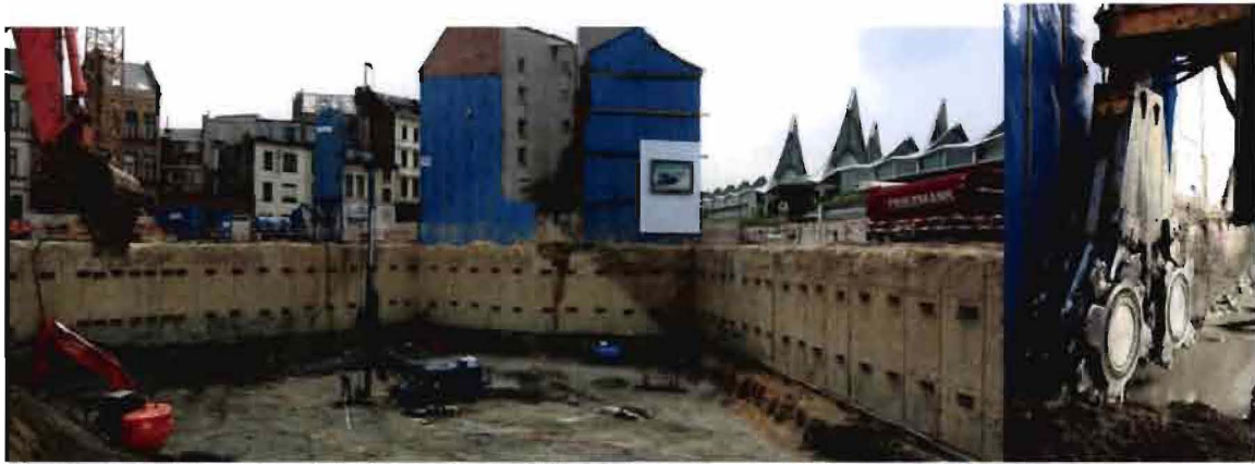
Abbeelding 2.5.10.1: een bouwkuip met een vervaardigde CSM-wand en de hydraulische frees (rechts) die bestaat uit twee tegengesteld draaiende snijwielen.
