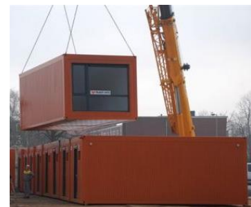
Fig 5.11 Plaatsing unit [G]
