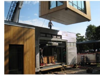
Fig. 5.27: Plaatsing modules [O]
