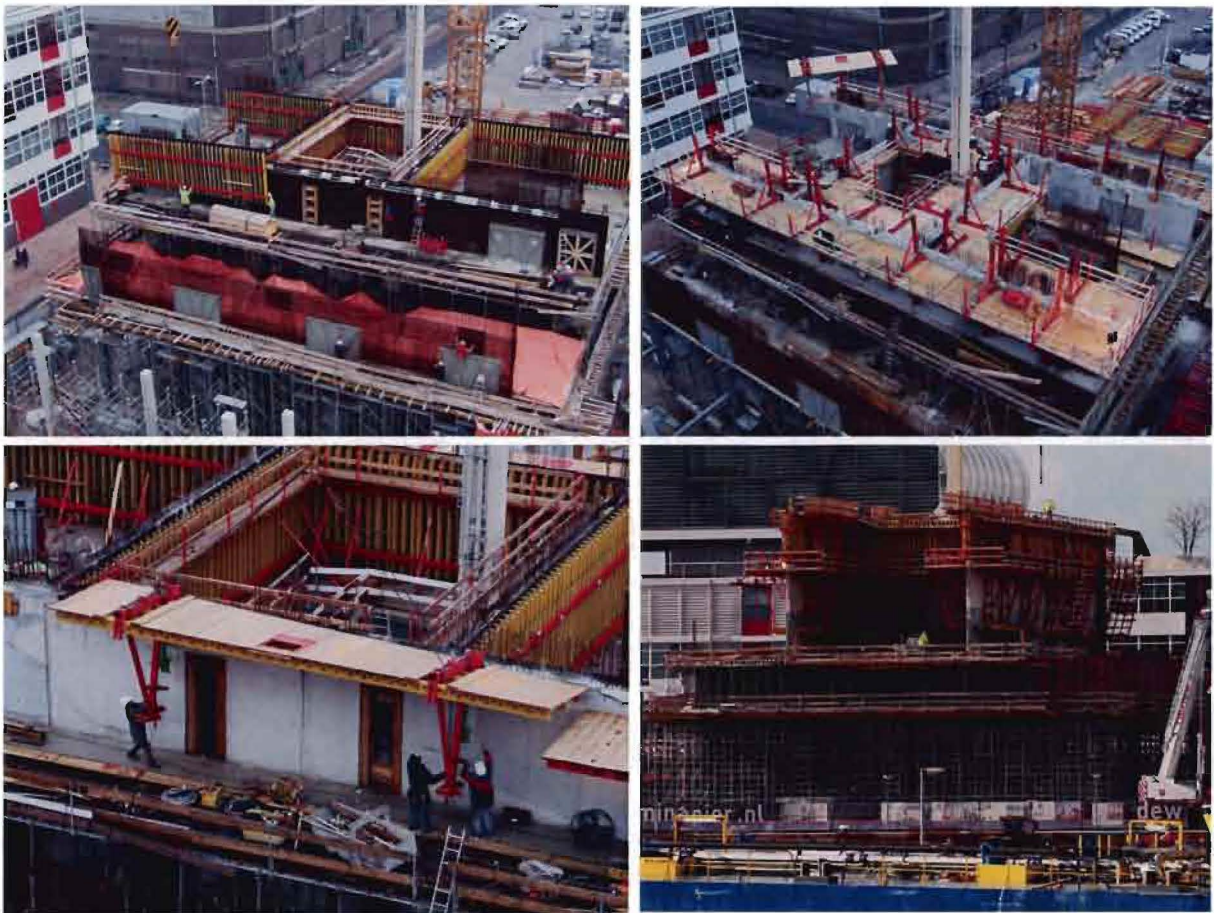
Figuur 36: Montagevolgorde van de ACS-R klimsysteem voor de H-wanden in vier fasen aangegeven
