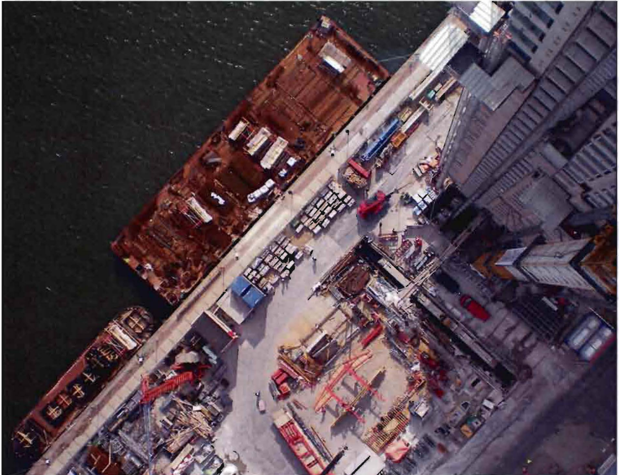
Figuur 63: Toepassing ponton voor het uitbreiden van het bouwterrein
