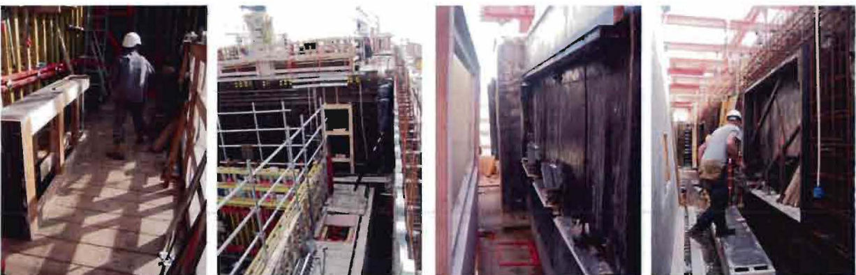
Figuur 47: Toepassing van sparings (traditioneel en klap)
