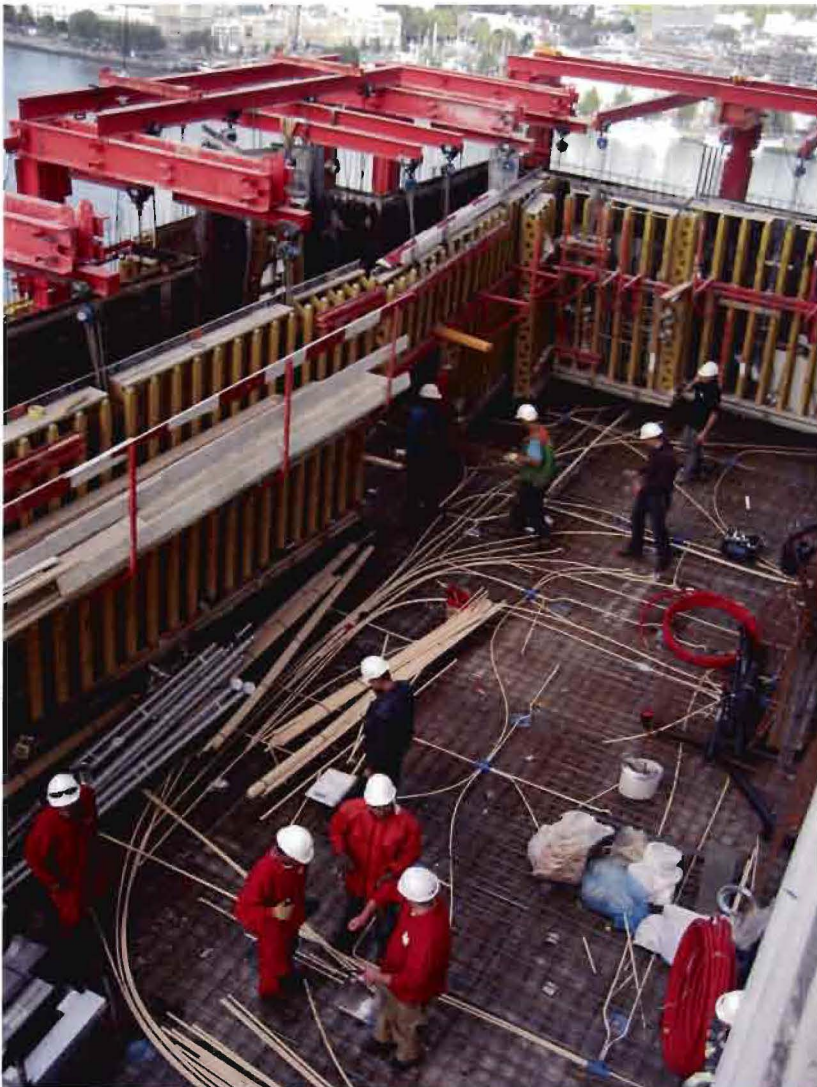
Figuur 12: 5 installateur en 4 vlechters op 190 m 2 werkoppervlak geeft 21 m 2 per werknemer
