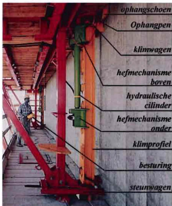
Figuur 20: Onderdelen klimsysteem
