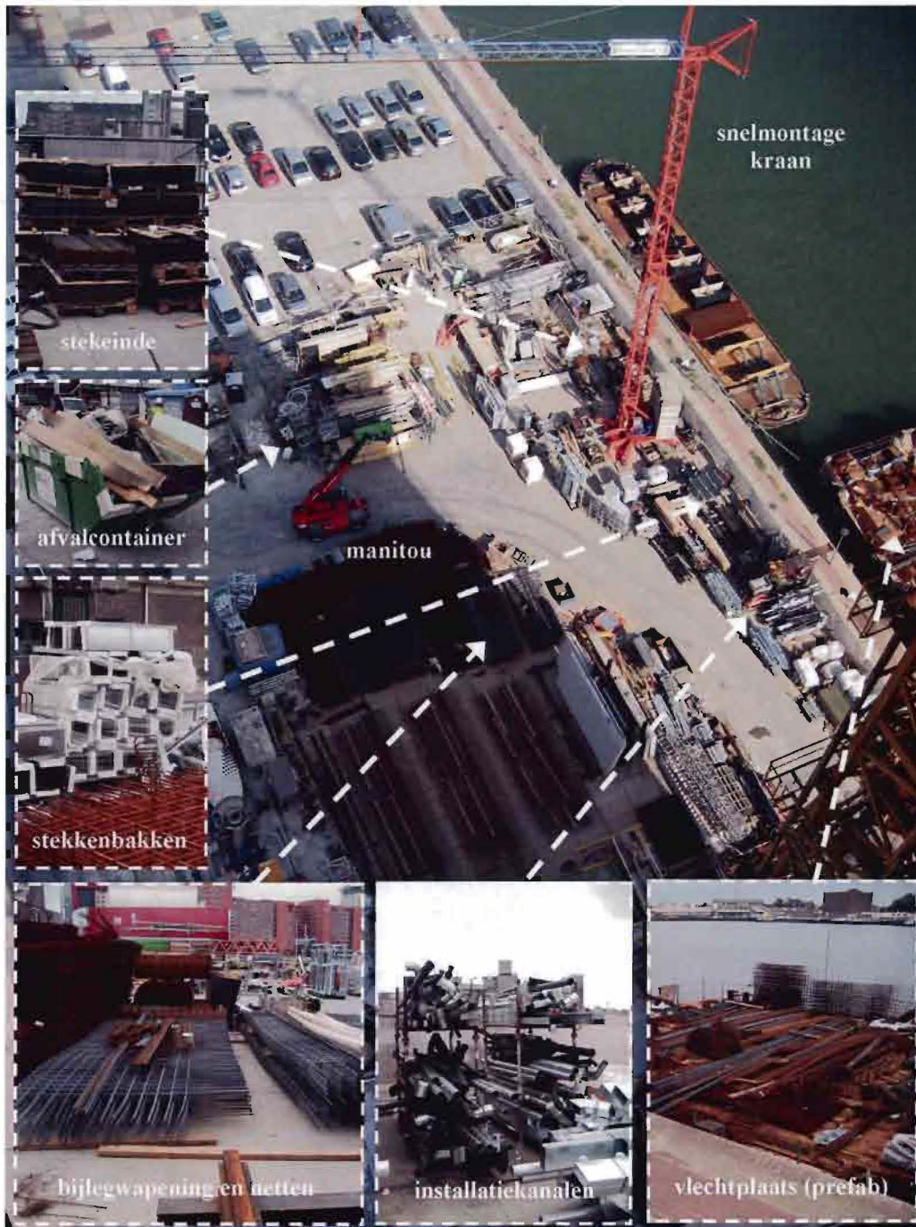
Figuur 62: Logistiek op de bouwplaats
