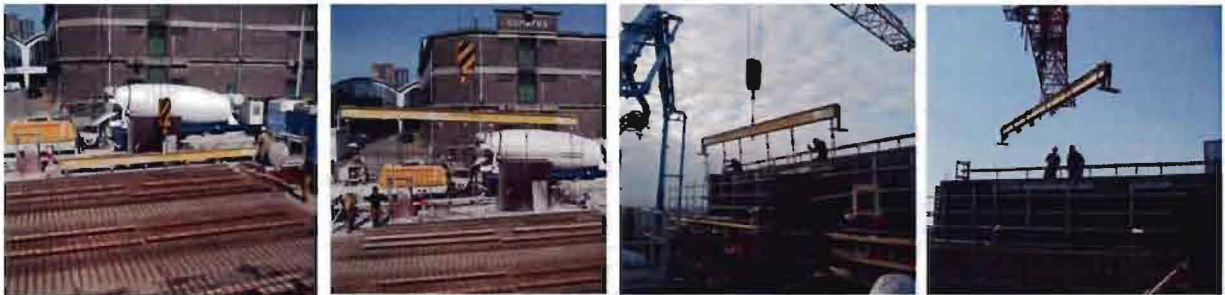
Figuur 49: Transport prefab wapeningselementen
