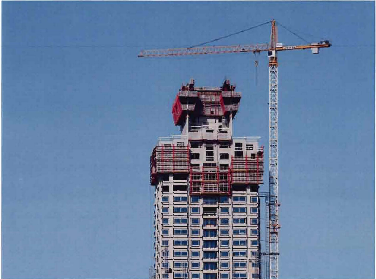
Figuur 70: Aanzicht woontoren New Orleans met de torenkraan
