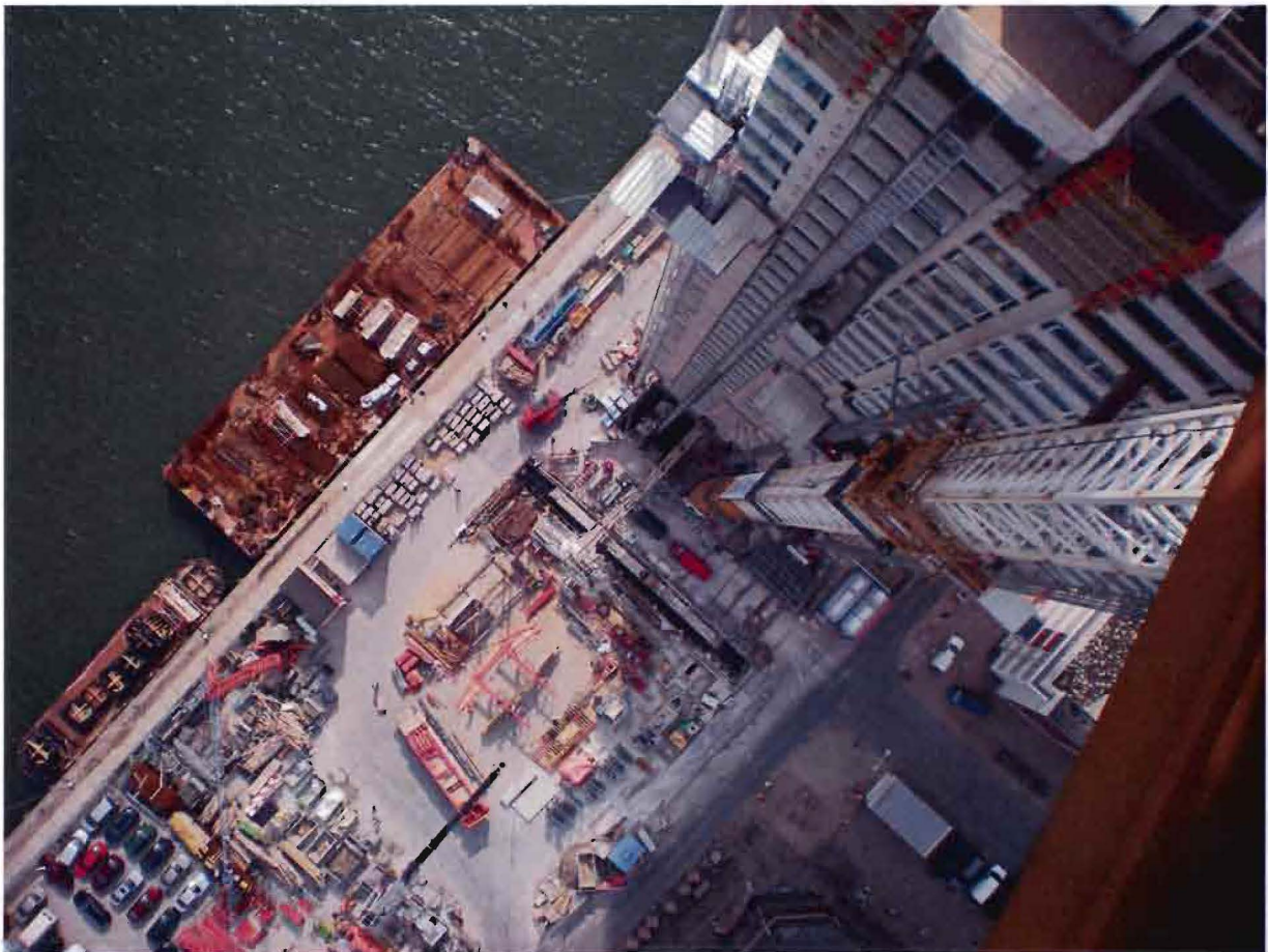
Figuur 61: Bovenaanzicht van de bouwplaats van het project New Orleans
