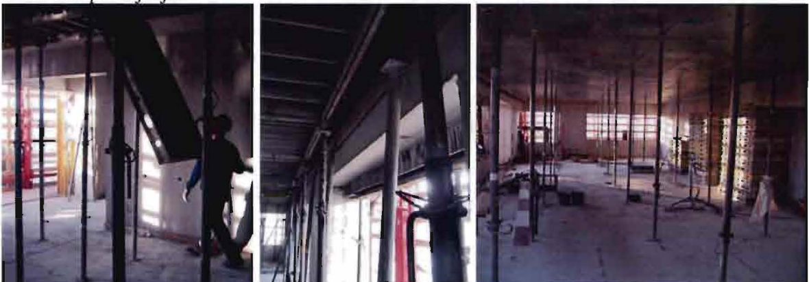
Figuur 43: Stappenplan van demontage paneelbekisting
