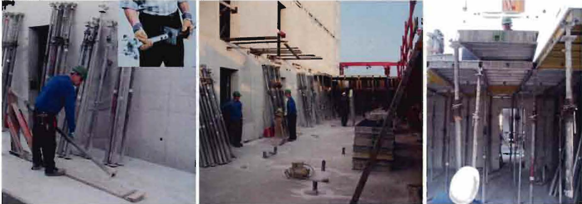
Figuur 42: Stappenplan van montage paneelbekisting
