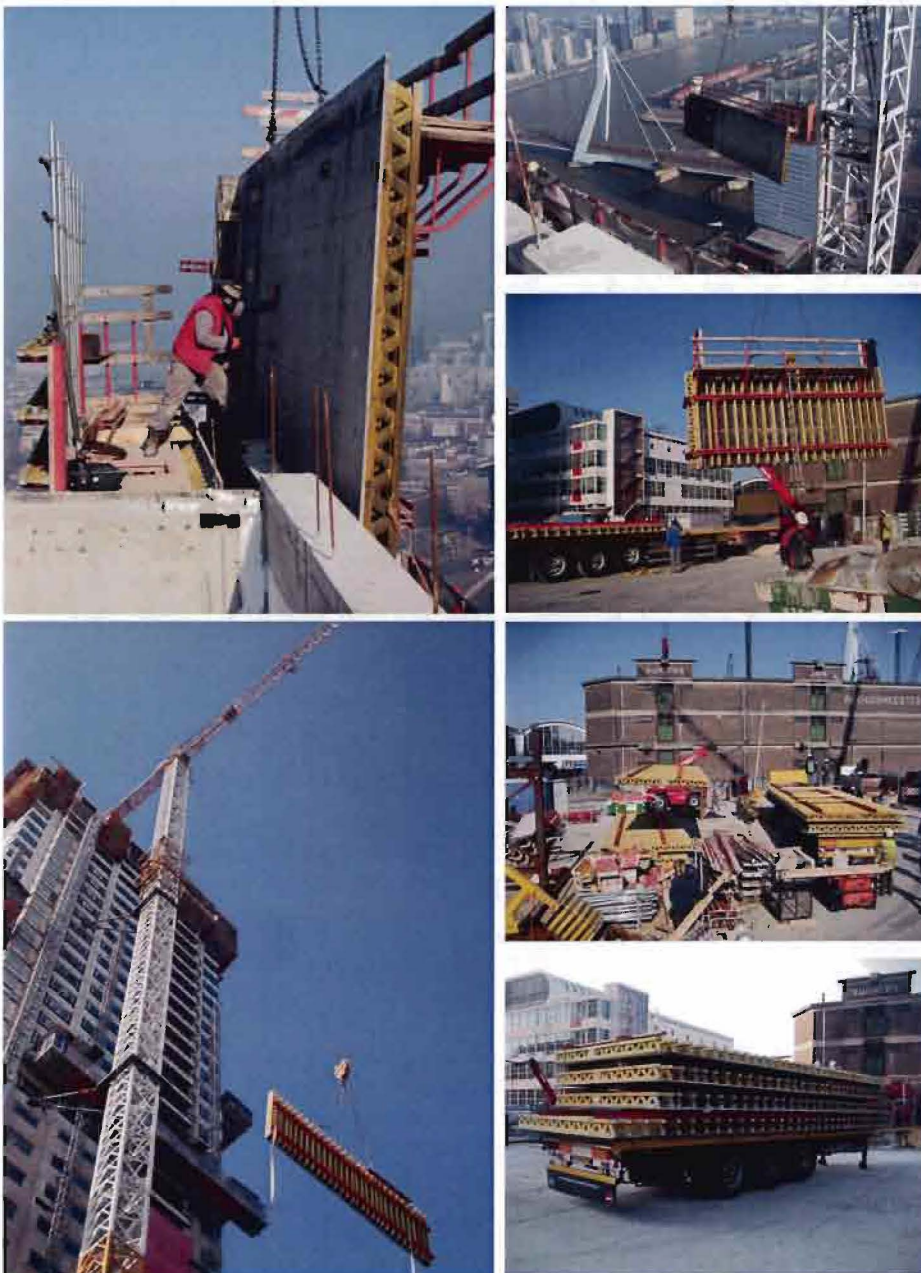
Figuur 38: Demontage van de bekistingschotten van de klimbekisting
