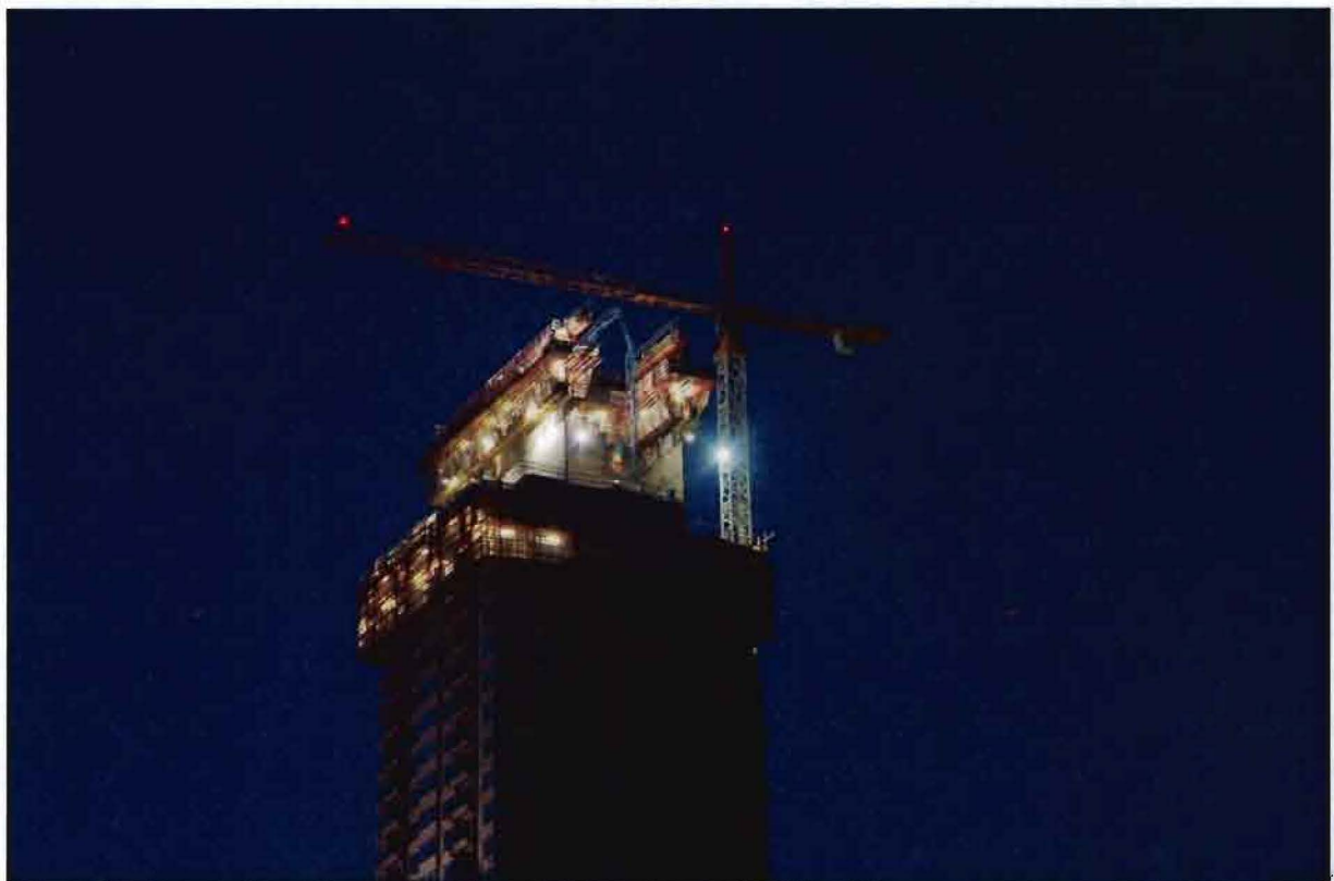
Figuur 11: Overwerken tijdens een ruwbouwcyclus op het project New Orleans
