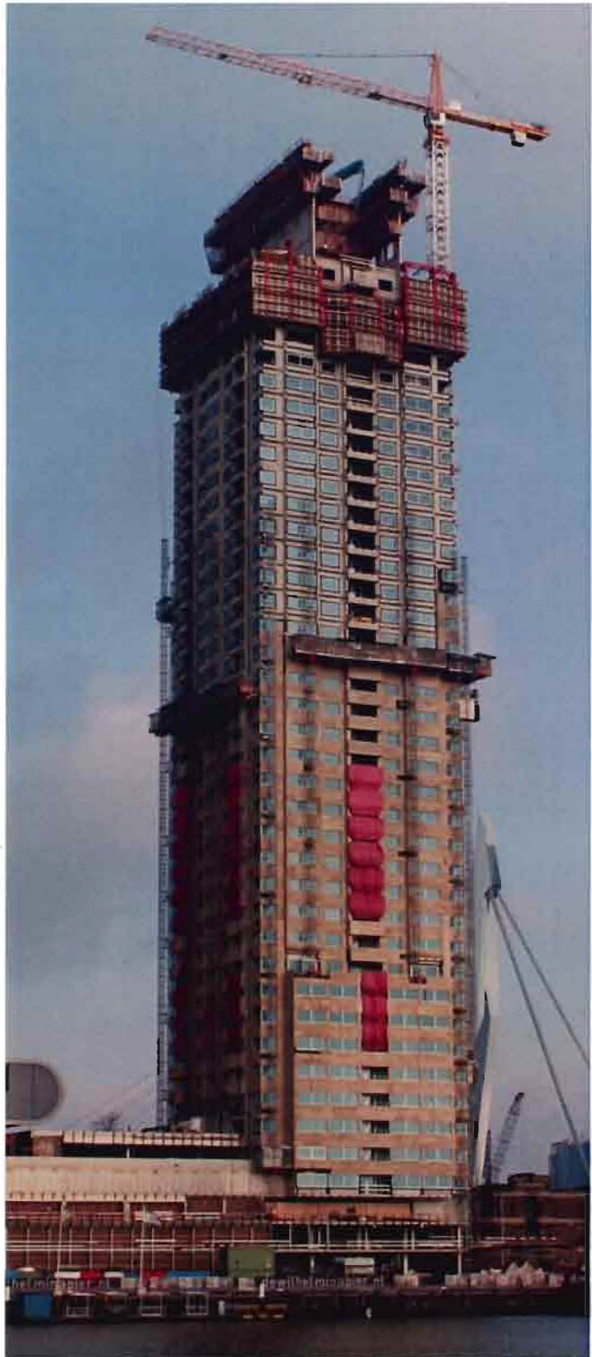
Figuur 4: Hoogbouwproject New Orleans te Rotterdam
