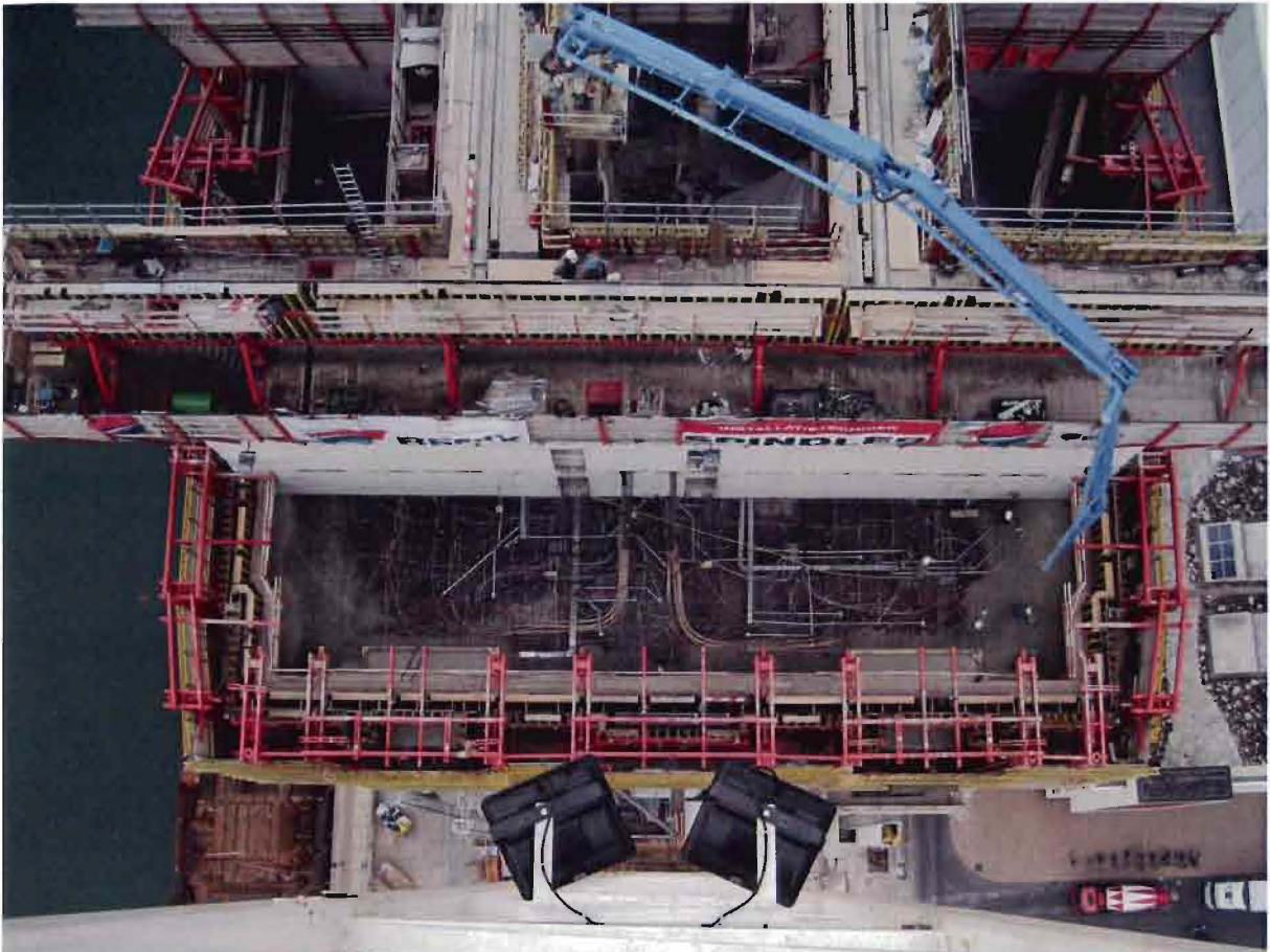
Figuur 55: Inzet betonpomp met verdeelgiek voor het afstorten van de vloeren en wanden op project New Orleans
