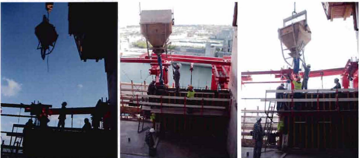
Figuur 58: Betonstorten met behulp van een betonkubel en torenkraan
