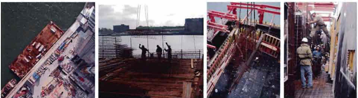
Figuur 50: Werkwijze semi-prefab wapeningselementen
