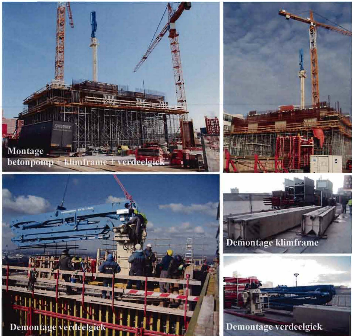
Figuur 76: Montage en demontage betonpomp
