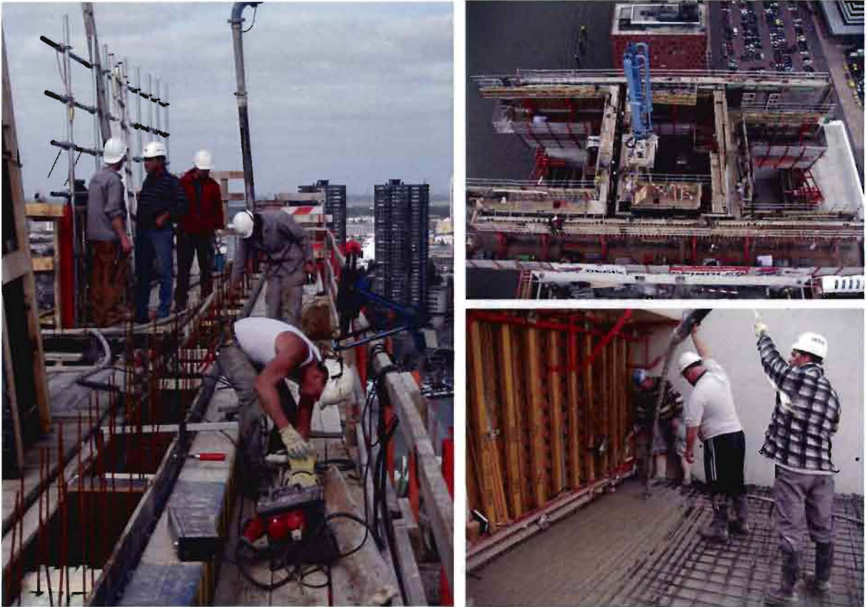
Figuur 57: Betonstorten met behulp van een betonpomp
