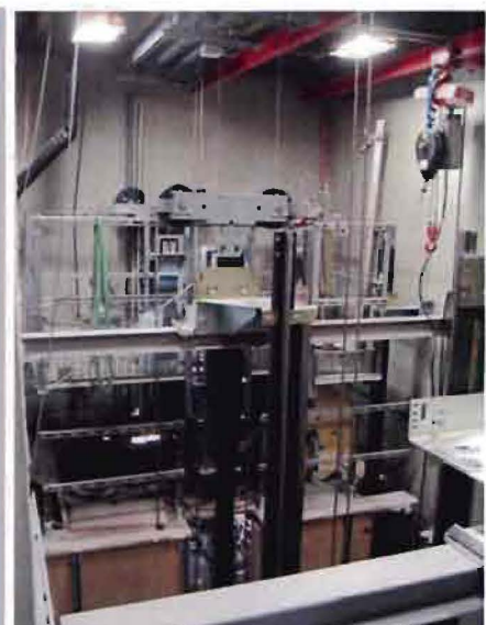
Figuur 72: Werkwijze jumplift ter plaatsen van de liftschacht in het kerngebied van project New Orleans
