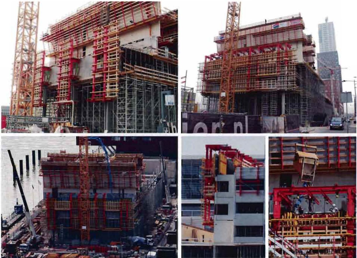
Figuur 37: Montagevolgorde van de ACS-G klimsysteem voor de façade wanden in vier fasen aangegeven
