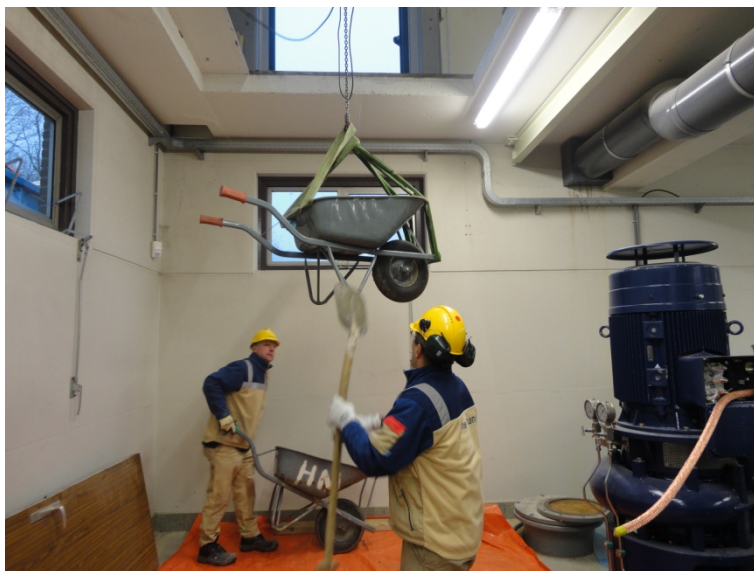
Afbeelding 5.1: 'Interne transportwegen'; intern niveauverschil overwinnen om te kunnen storten.
