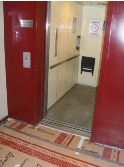
Afbeelding 5.5: 'Liftgebruik bestaande liften in pand'; bestaande lift wordt gebruikt door bouwplaatspersoneel en klant (Bruijn, 2011).
