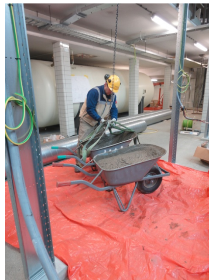
Afbeelding 5.2: 'Aan- en afvoer door bestaand pand'; transporteren van kruiwagens beton door bestaande situatie.
