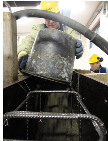
Afbeelding 5.4: 'Beschikbaarheid groot materieel'; Ook de emmer was benodigd om de kist te vullen met betonspecie.
