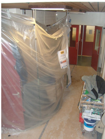
Afbeelding 5.9: 'Bescherming van te handhaven gebouwdelen (Bruijn, 2011).
