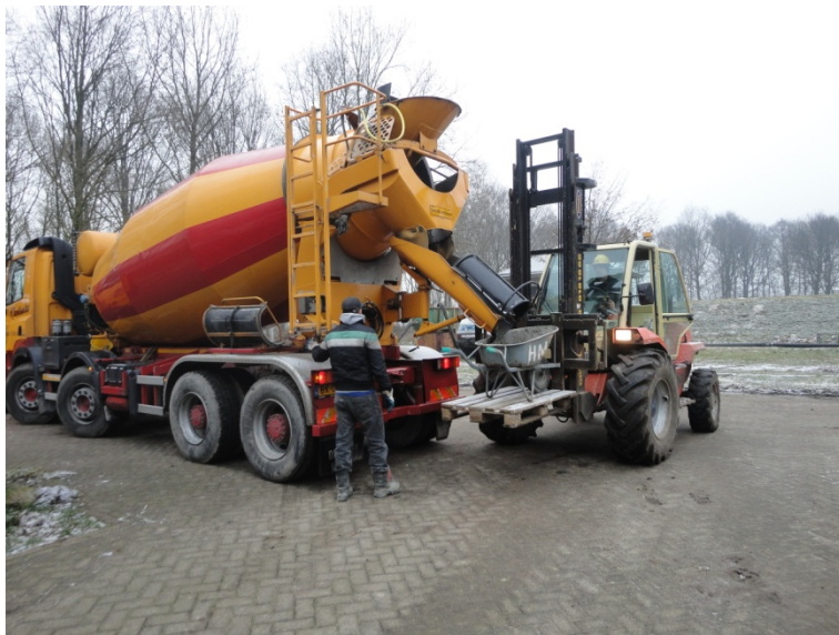
Afbeelding 5.3: 'Beschikbaarheid groot materieel'; Men kan niet storten met de betonpomp, maar moest met behulp van kruitwagens de beton richting bekisting transporteren (horizontaal en verticaal).
