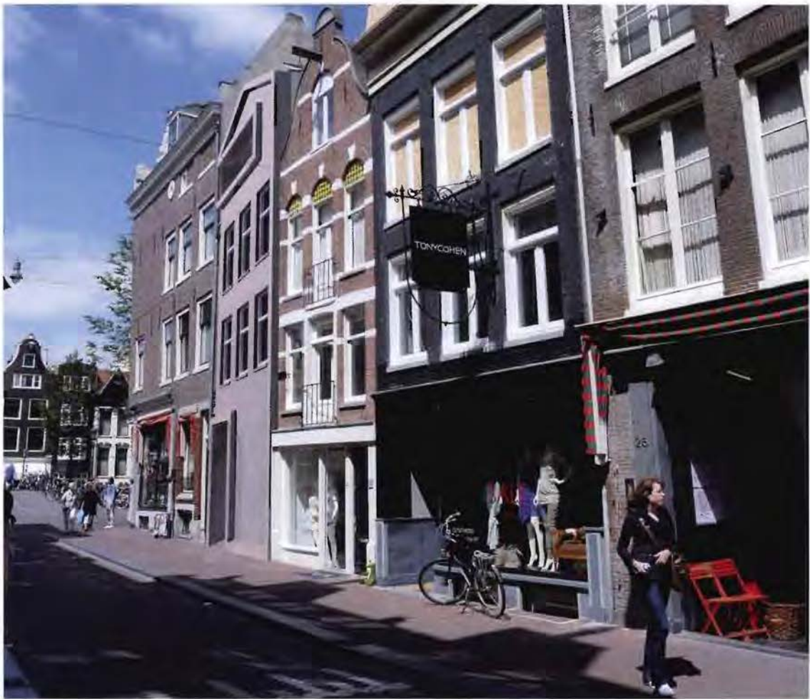
Gevel aan Huidenstraat.
