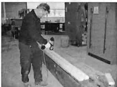
FIGUUR 5.2.4 LIJMEN GLEUVEN
