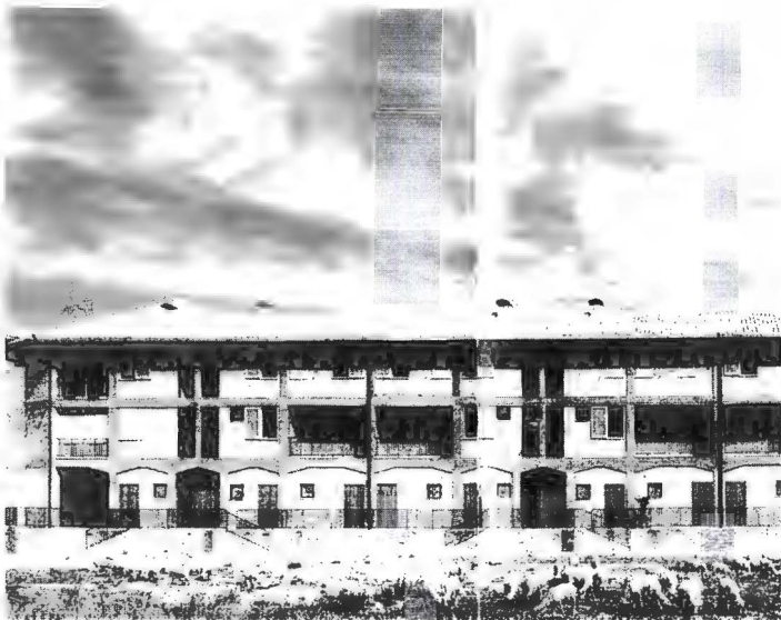
afb. 11. Bouwblok in Matera, Giancarlo De Carlo, 1959 ←
