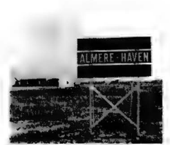
afb. 30. Almere Haven in aanbouw, 1976 ↑
