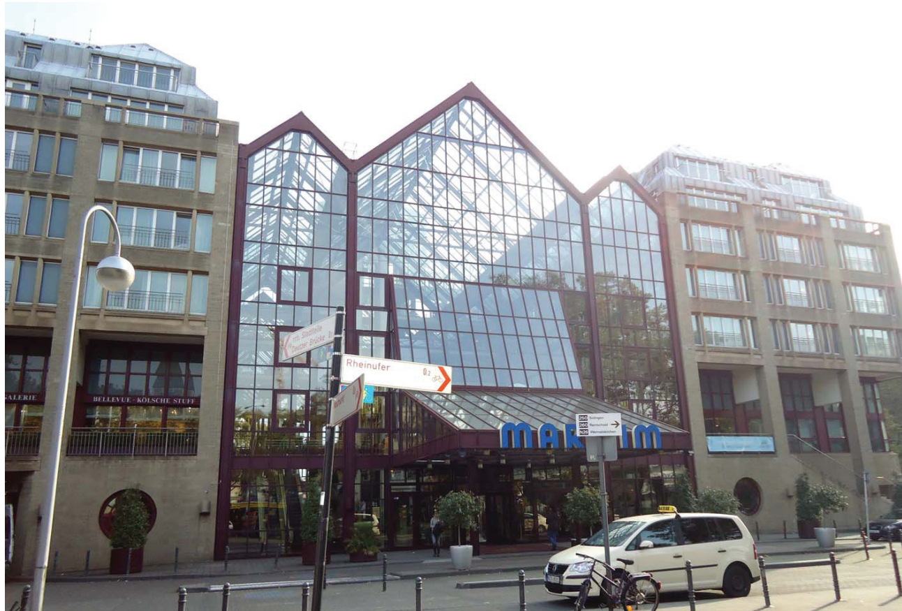
afb. 26 Beeld van de westgevel van het Maritim Hotel
