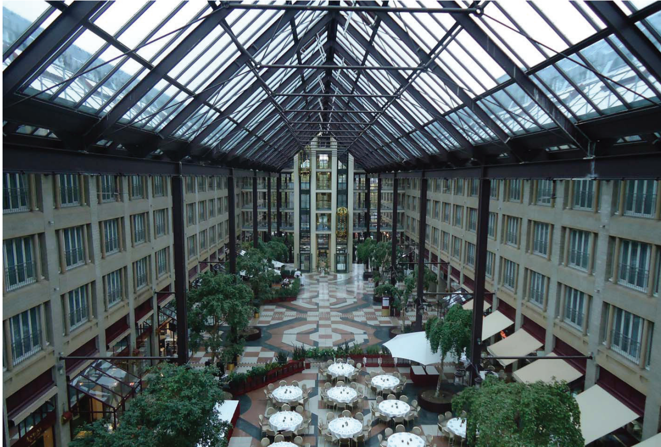
afb. 28 Beeld van de passage in westelijke richting
