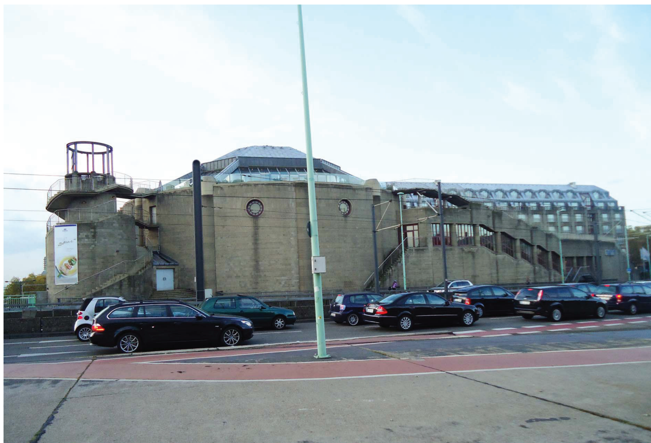
afb. 24 Beeld van de noordgevel van het Maritim Hotel en de aangrenzende drukke verkeersader, de Deutze Brücke
