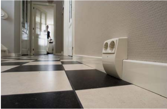
Figuur 77: KISS Systeem, gootprofiel welke aan te passen is aan de wensen van de gebruiker 14
