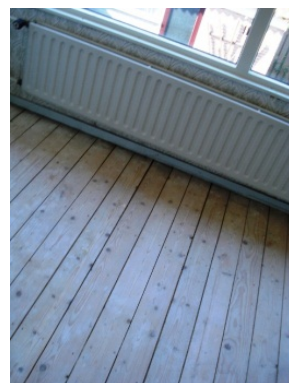
Figuur 43: Houten verdiepingsvloer
