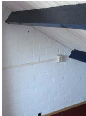
Figuur 46: Balklaag en opbouw van installatieleiding
