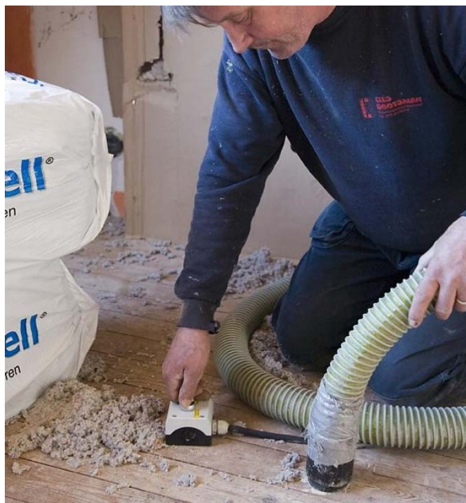
Figuur 93: De isolatievlokken worden met behulp van een inblaasmachine in het vooraf geboorde gat gespoten 26 .
