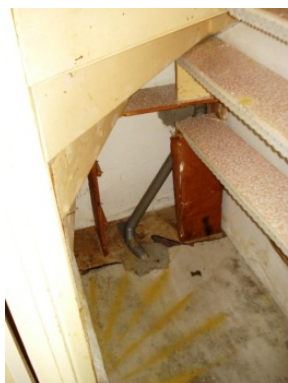
Figuur 42: Begane grondvloer van stampbeton
