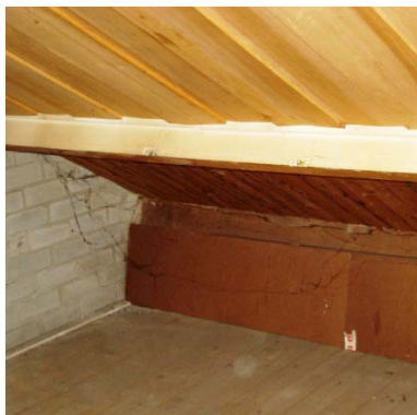
Figuur 87: Foto van het huidige dak 20
