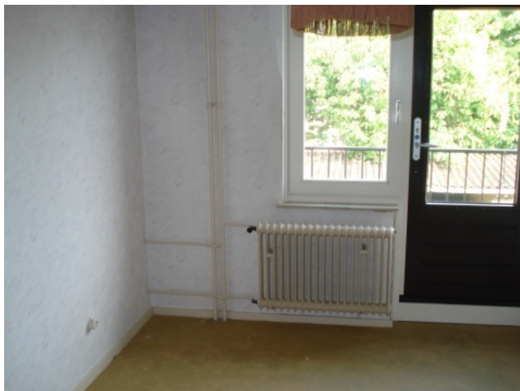
Figuur 29: Leidingen in het zicht Winterjanstaat 2 te Eindhoven Bron: (S Koenen, 2011)
