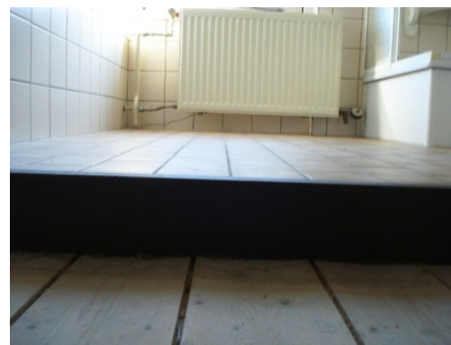
Figuur 44: Betonnen vloer t.p.v. badkamer, t.b.v afvoer
