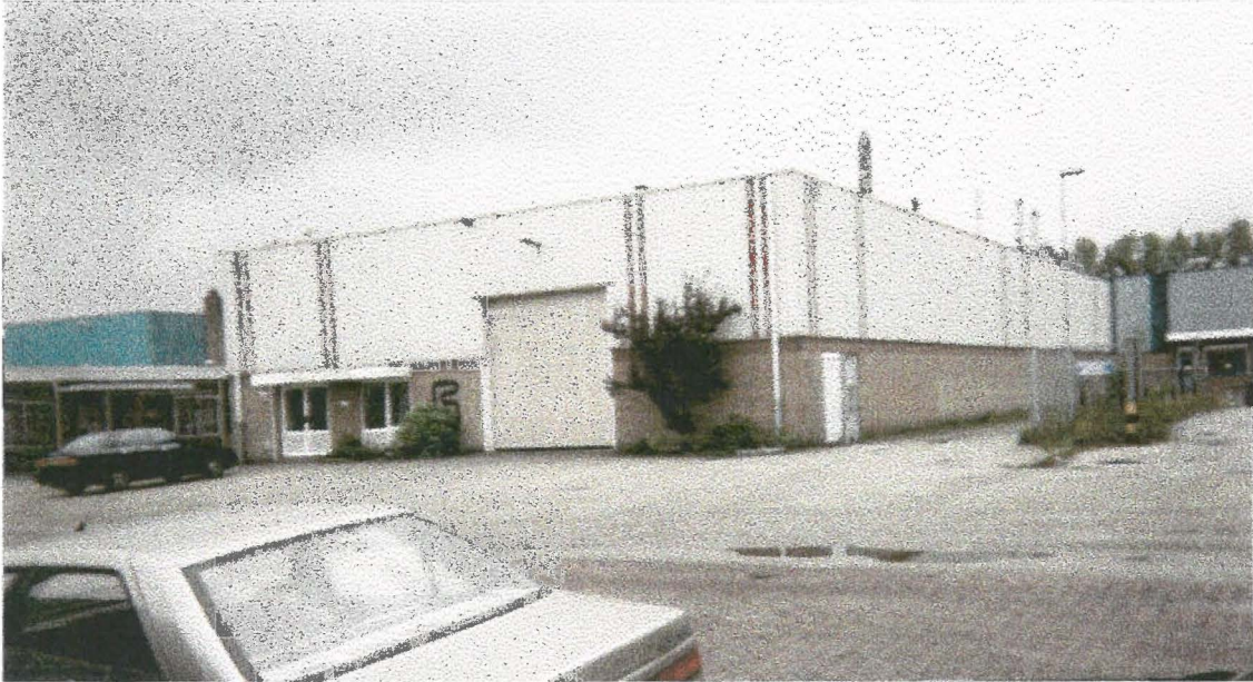
figuur 6.12: Bedrijfsgebouwtype 3/6. Metalen gevelbekleding in combinatie met metselwerk, kantoorruimte inpandig.
