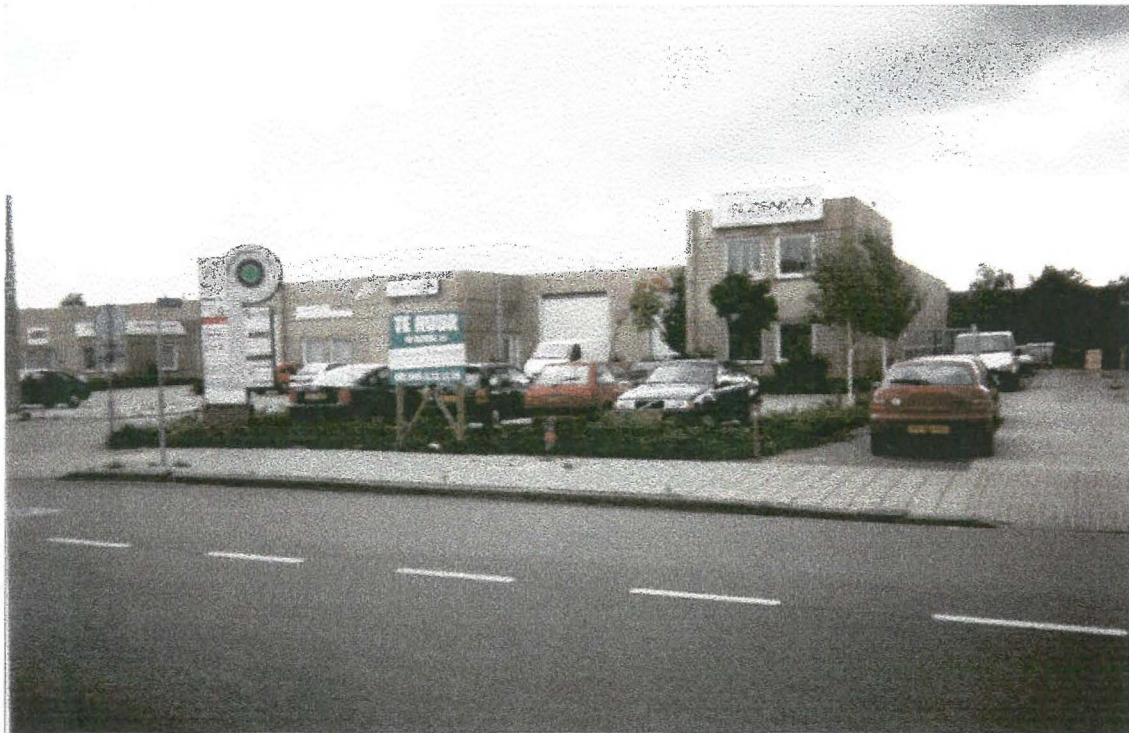
figuur 6.10: Bedrijfsgebouwtype 1/4. Gemetselde gevels, kantoorruimte inpandig.
