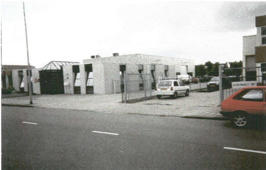
figuur 6.13: Bedrijfsgebouwtype X. Hal met metalen gevelbekleding, kantoorruimte opgebouwd in metselwerk, voor de hal geplaatst.
