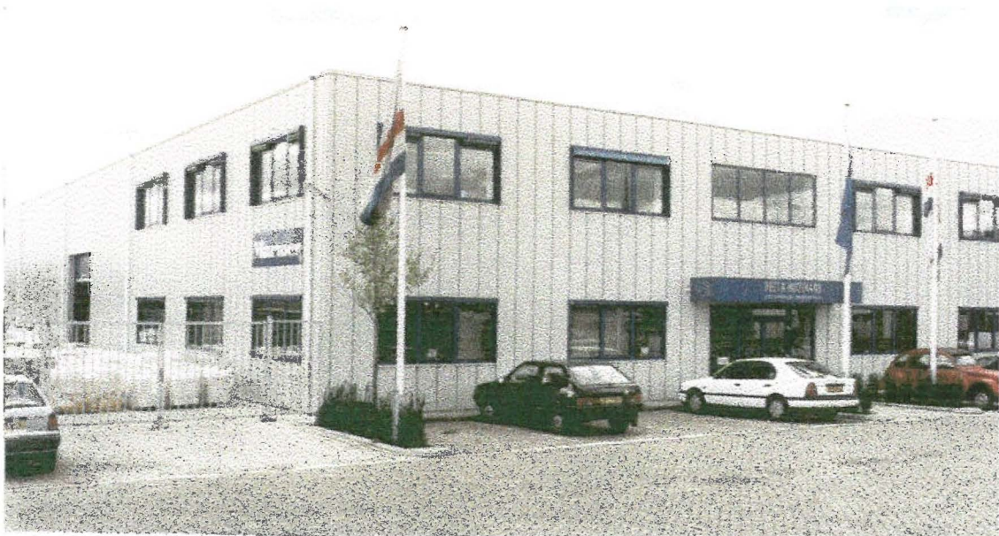
figuur 6.11: Bedrijfsgebouwtype 2/5. Metalen gevelbekleding, kantoorruimte inpandig.
