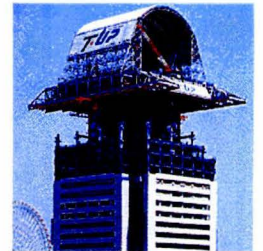
Afbeelding 02 T-up bouwsysteem van Taisei Corporation
