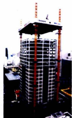
Afbeelding 17 Big Canopy bouwsysteem in gebruik in Tokyo (Jp)
