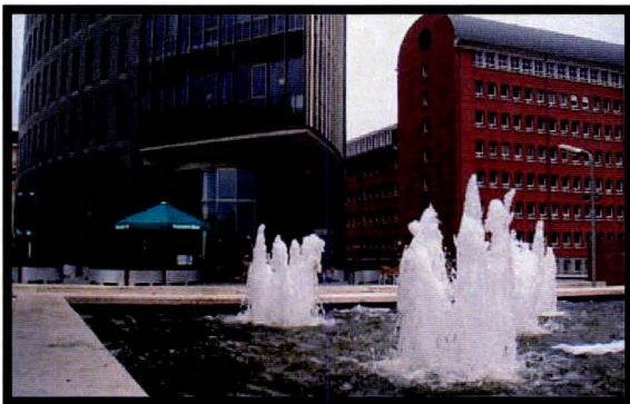
figuur 12. Complex 'Riva' aan de kop van het Bassin
