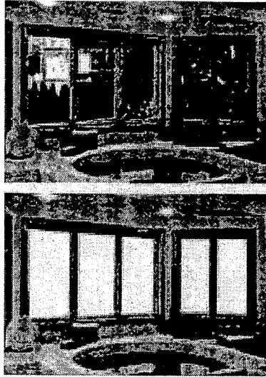
Figuur 1.6: Voorbeeld van ramen gemaakt van PDLC-materiaal. Met een druk op een knop kan het raam doorzichtig of ondoorzichtig gemaakt worden [40].
