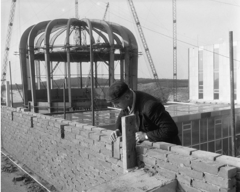
Bouw Reactorcentrum Nederland te Petten, met op de achtergrond de Hoge Flux Reactor in aanbouw. Fotograaf: Harry Pot/Nationaal Archief, collectie Anefo.
