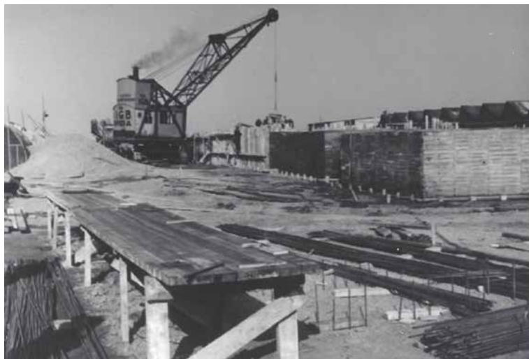
Bouw van caissons voor de Deltawerken in 1953.
