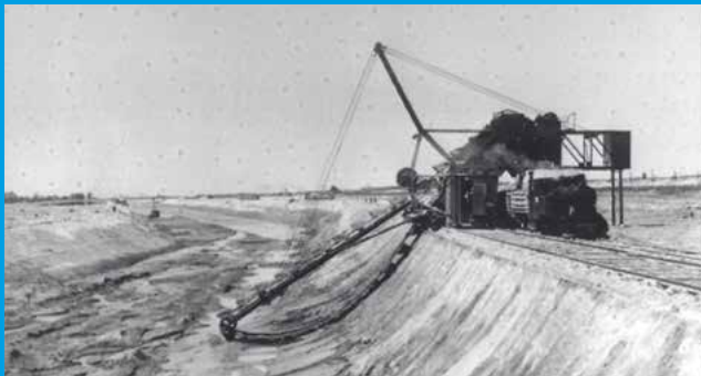
Grondverzet bij bouwprojecten werd in het laatste kwart van de 19 e eeuw steeds vaker machinaal gedaan door bijvoorbeeld excavateurs. Zoals hier bij graafwerkzaamheden voor de Nieuwe Maasmond
