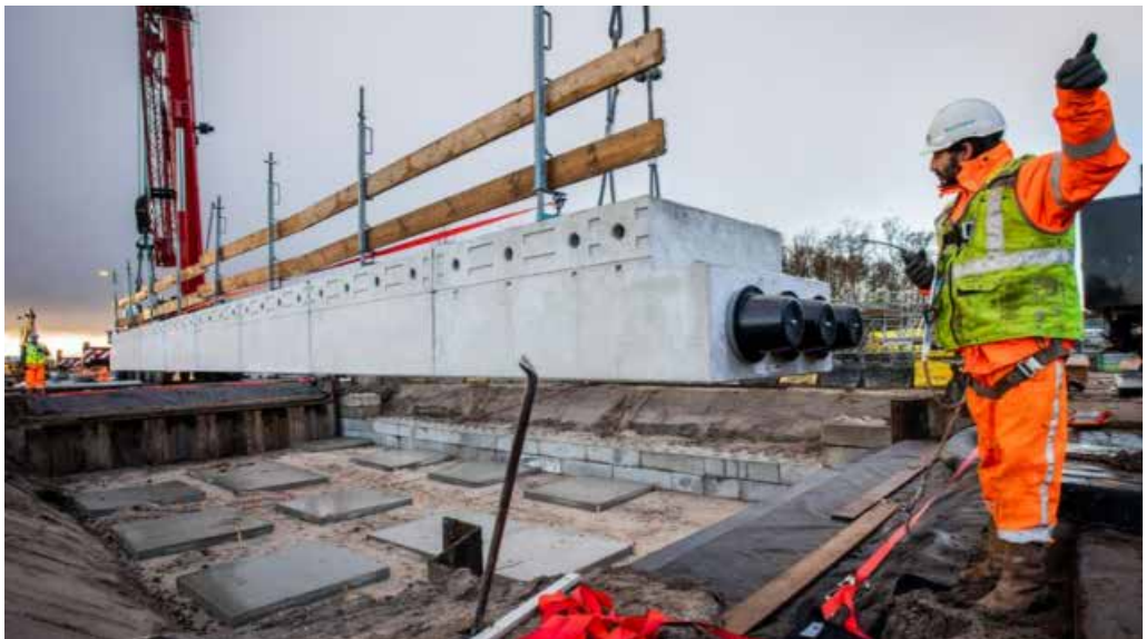
De bouw van het eerste circulaire viaduct.
