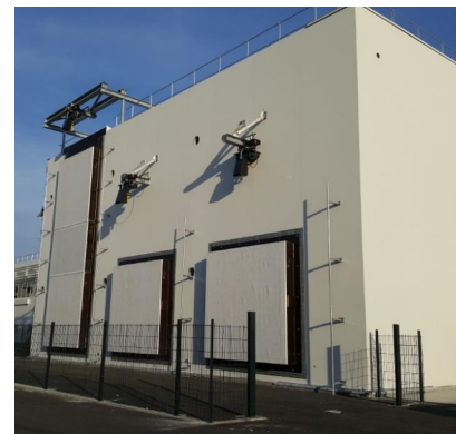
► Fig. 3: Façade test beds
