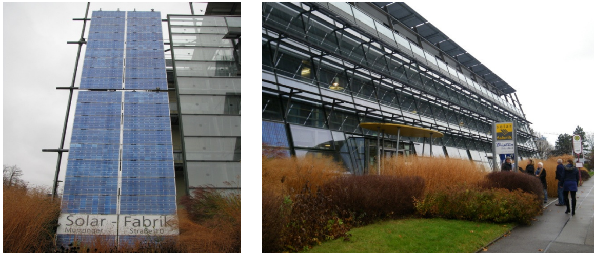
Figuur 6; De schuine gevel is aan de buitenzijde voorzien van PV-panelen
