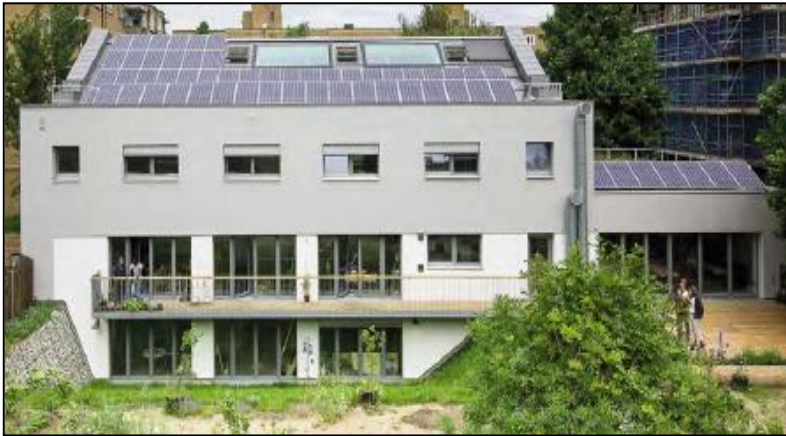
Figuur 14. Aanzicht zuidzijde 'Mayville Community Centre'
