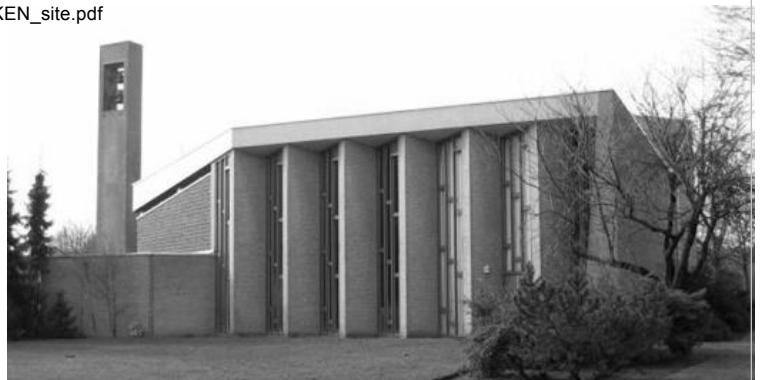
afb 9 | Achterzijde maranathakerk met op de achtergrond de klokkentoren die in 2009 is afgebroken vanwege betonrot, bron: Wikipedia
