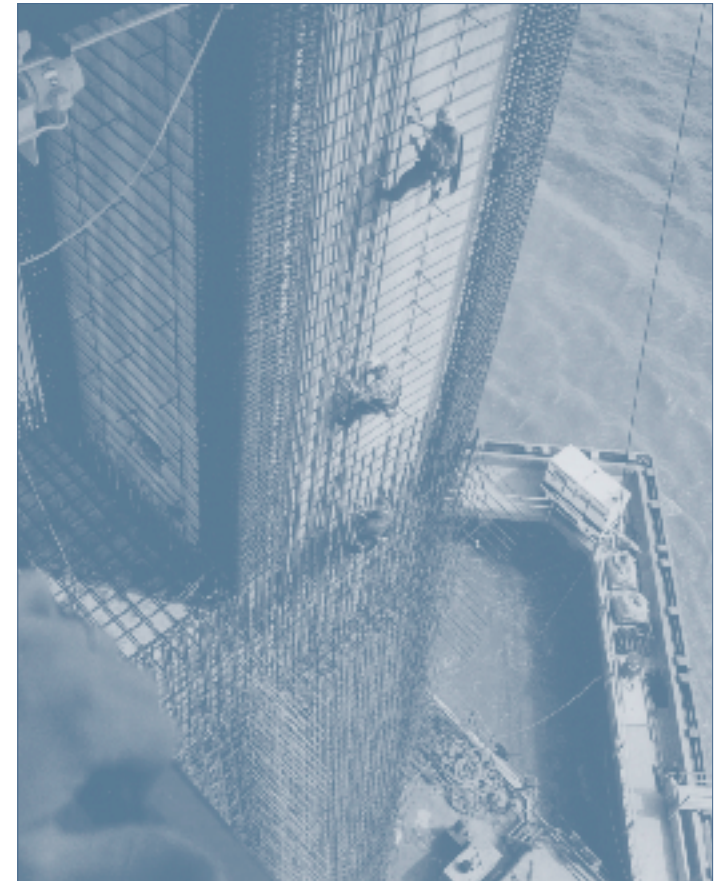
Betonstaalvlechters aan het werk op grote hoogte
