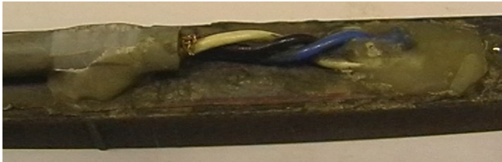
foto 9: montage rekstrook, afgedicht met was
