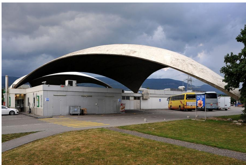
Afbeelding 2. Betonnen schaalconstructie van Heinz Isler te Ratstätte, Deitingen Süd (Zw, 1968). Bron: fr.wikipedia.org
