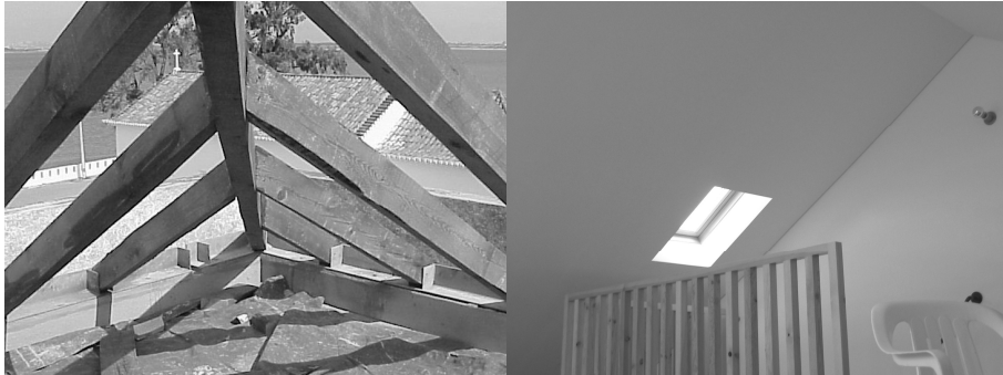
Figure 64 – Casa Pereira da Silva (attic), in Moita – Portugal (Mestre & Aleixo, 2002)
