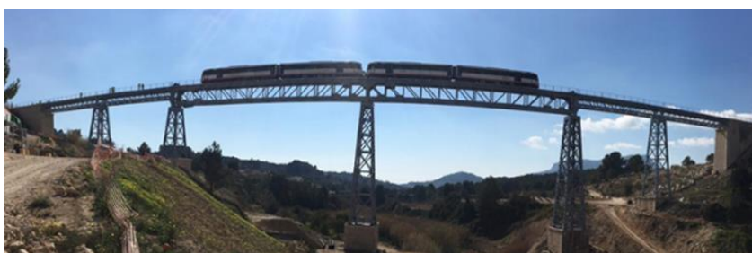
Figura 5.1: Vista generale del Viadotto.
