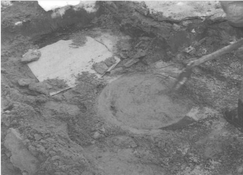
Bild 2: Freigelegter Säulenkopf [1].
