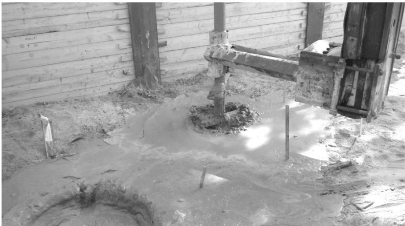
Bild 3: Herstellung der Bodenmischsäulen [1].
