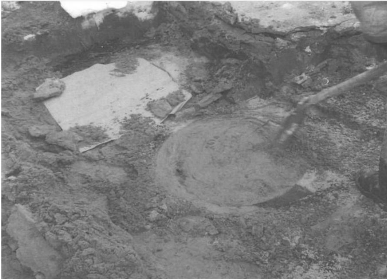
Bild 2: Freigelegter Säulenkopf [I].
