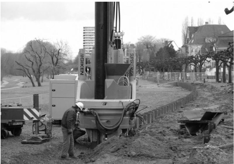
Bild 16: Einbringen von Doppel-Z-Bohlen mit Crush Piler [II].
