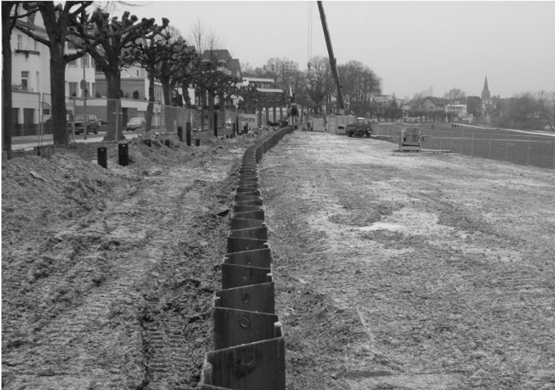
Bild 17: Eingespresste Doppel-Z-Profile [II].
