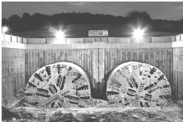
Bild 4: Zwei EPB-Schilde nach dem Durchstich für den Katzenbergtunnel [II].
