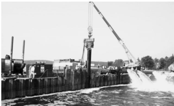
Bild 17: Sofortmaßnahmen im Notfall [II].
