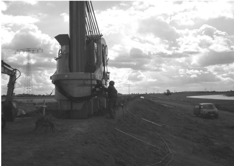
Bild 12: Bohr-Press-System (Crush Piler) im Einsatz an der Elbe [II].
