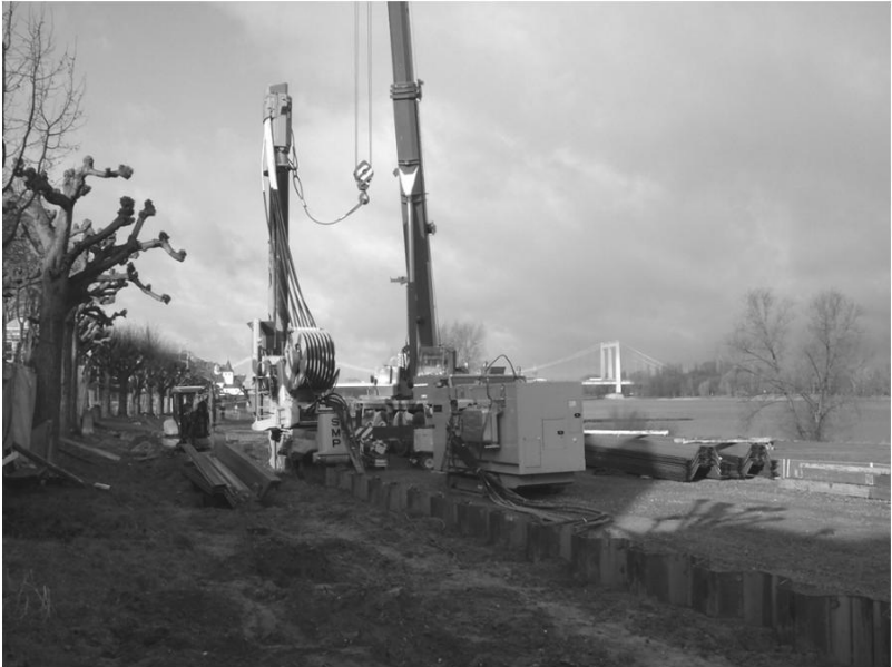
Bild 15: Crush Piler im Einsatz am Rhein [II].
