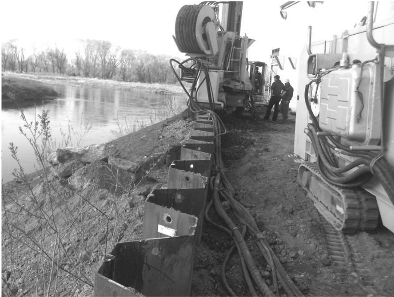
Bild 14: Bohr-Press-System (Crush Piler) im Einsatz an der Mulde [II].
