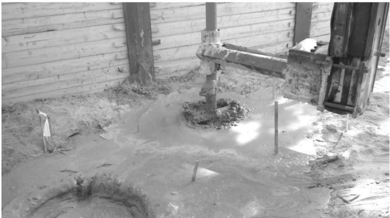
Bild 3: Herstellung der Bodenmischsäulen [I].
