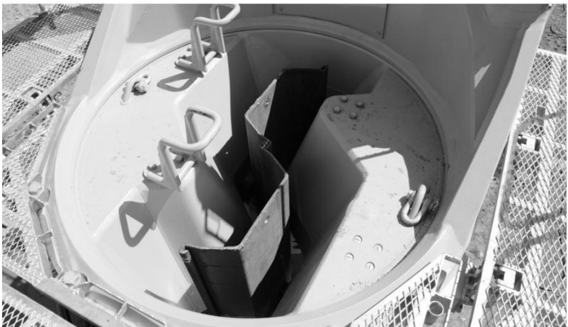
Bild 11: Einbringen von Doppel-U-Profilen [II].
