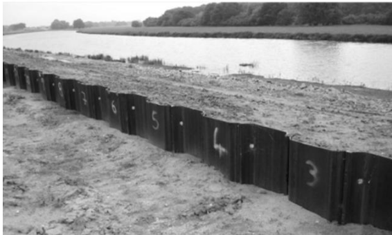
Bild 16: Sanierung und Ertüchtigung von bestehenden Hochwasserschutzanlagen [II].
