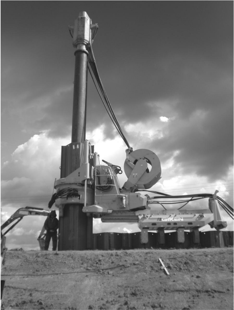
Bild 13: Einbringen von Doppel-Z-Bohlen durch Einpressen mit integriertem Vorbohren [II].
