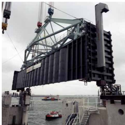
Bouw van de Oosterscheldekering, 1976-1986. Bron: Rijkswaterstaat
