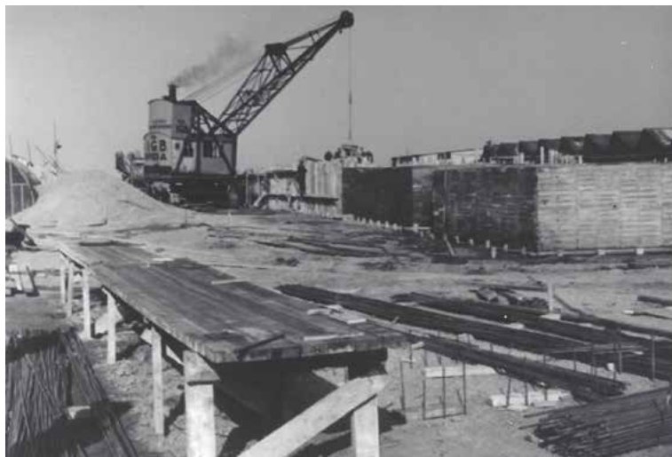
Bouw van caissons voor de Deltawerken in 1953.
