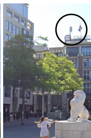
Figuur 26 Macro-antenne op de dakrand van het Grand Hotel Krasnapolsky op de Dam, Amsterdam (bron: Google)
