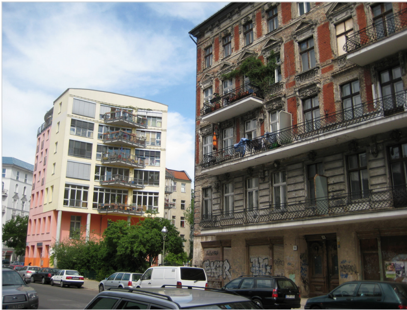
Abbildung 28: Neubau neben sanierungsbedürftigem Wohngebäude in der Lübecker Straße
