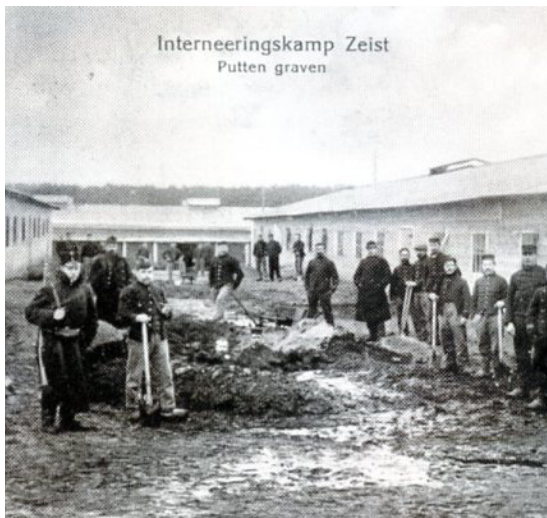
H8. Interneringskamp Zeist - Raven, G (2012)
