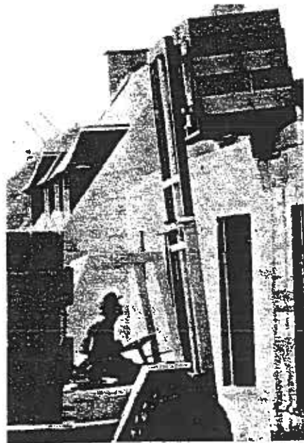
Plaatsen van een pallet met betonblokken op een verdieping.
