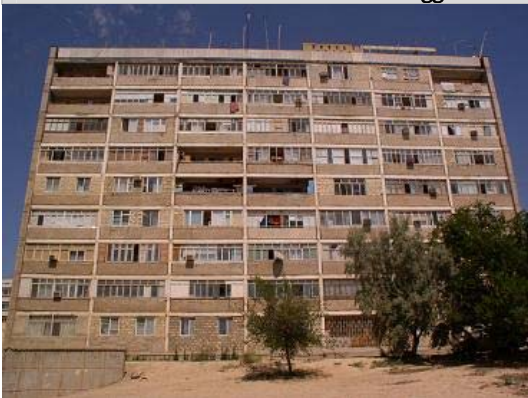
Abb. 26 - Individuelle Umbauten der Loggien
