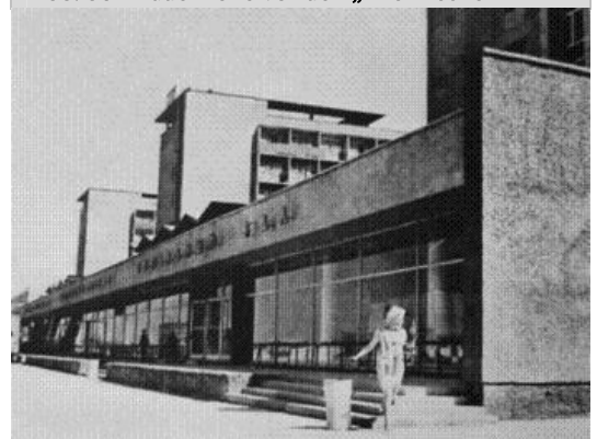
Abb. 50 - Ladenzeile vor den „Drei Recken“
