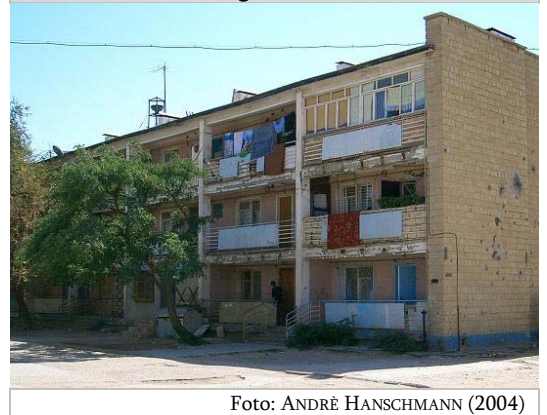
Abb. 54 - Laubenganghaus im dritten Mikrorayon (aus Muschelkalk gemauert)
