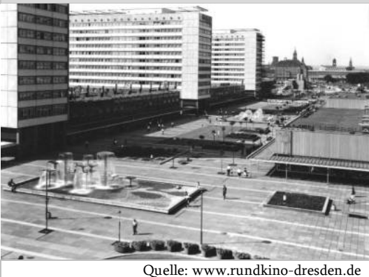
Abb. 31 - Historische Aufnahme der Prager Straße in Dresden
