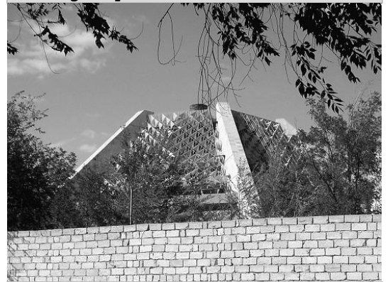
Abb. 45 - Ansicht Dachkonstruktion des Wintergartenpavillons
