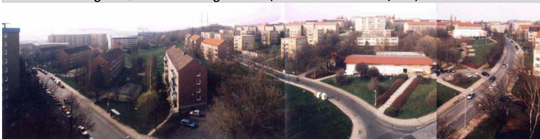
Abb. 36 - Wohngebiet „Bieblacher Hang“ in Gera (errichtet 1958-1970er Jahre)
