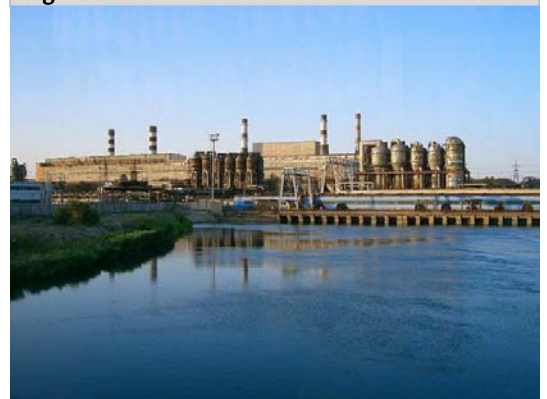
Abb. 42 - Reaktor und Meerwasserentsalzungsanlage
