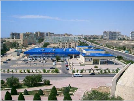
Abb. 22 - Neu errichteter Geschäftskomplex „Ardager“ im neunten Mikrorayon
