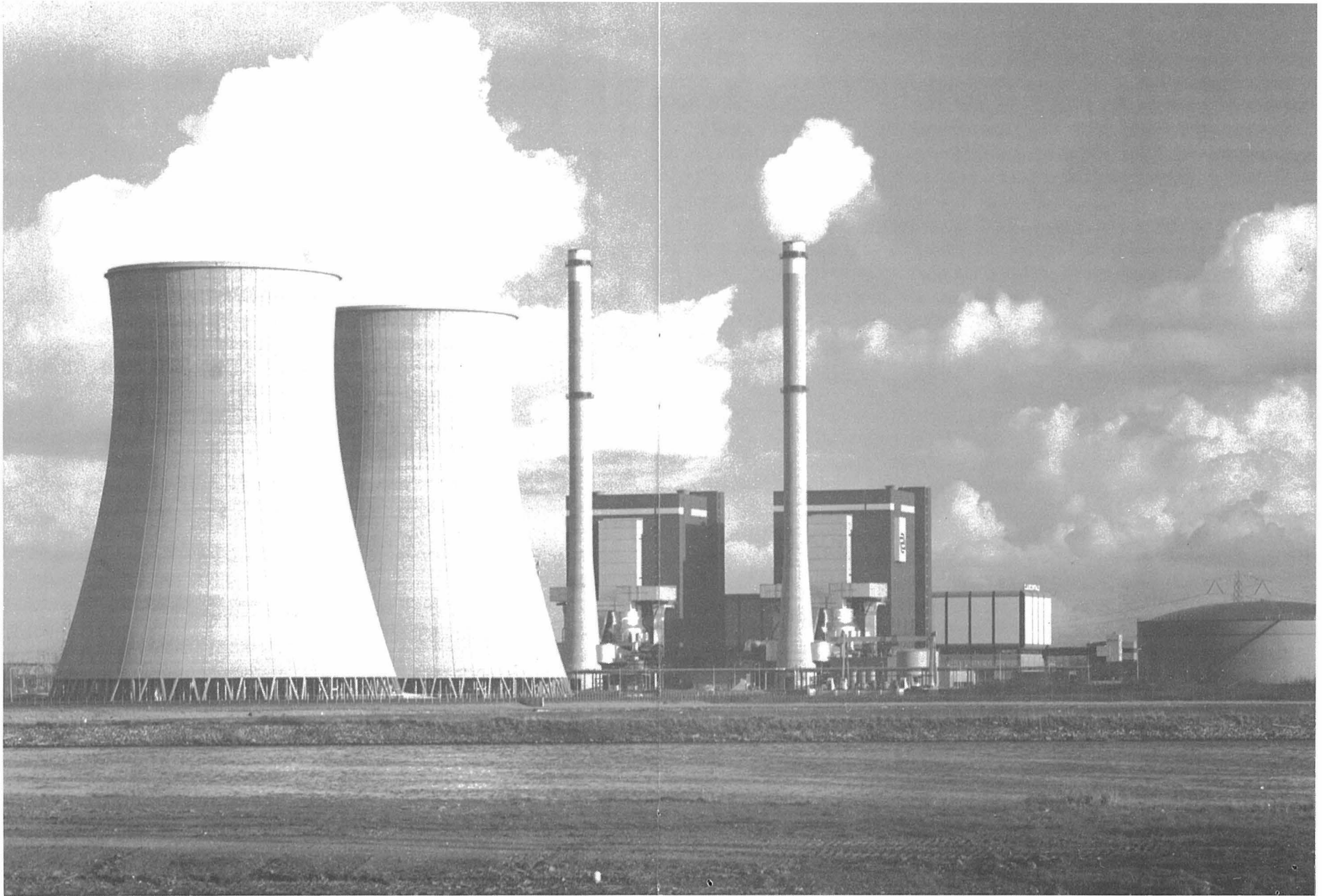
Figuur 2 De Clauscentrale in Maasbracht. Duidelijk zijn te zien de beide koeltorens, de schoorstenen, de hoge ketelhuizen met daarachter de lichter gekleurde machinal. De koeltorens zijn 116 m hoog, de schoorstenen 150 m.
