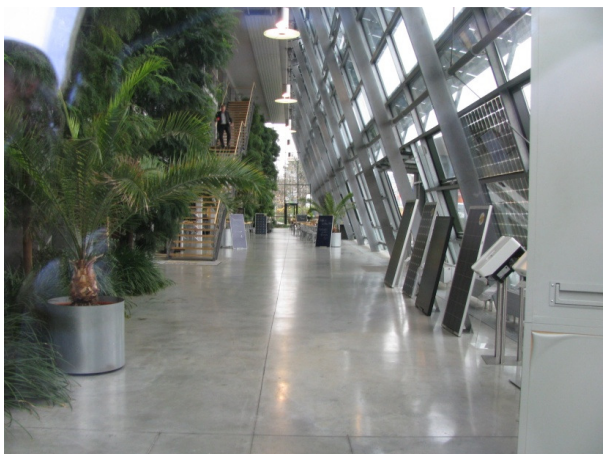
Figuur 5; Interieur van de Solar-Fabrik, gekenmerkt door de schuine gevel voorzien van PV-panelen
