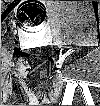
Het "inklikken" van een module in het distributiesysteem
