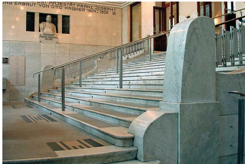
Figuur 43. In het interieur wordt ook veelvuldig marmer en aluminium toegepast. De subtiele aluminium bouten komen door het gehele gebouw terug, zo ook in de trap.
