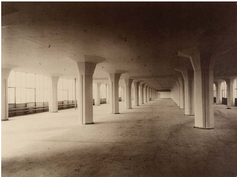
Figuur 95. De paddenstoelvormige betonkolommen in een 'vrije' hal.
