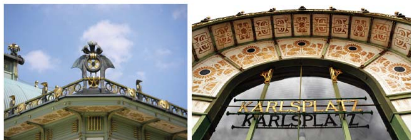
Figuur 66. Station Karlsplatz, Wenen
