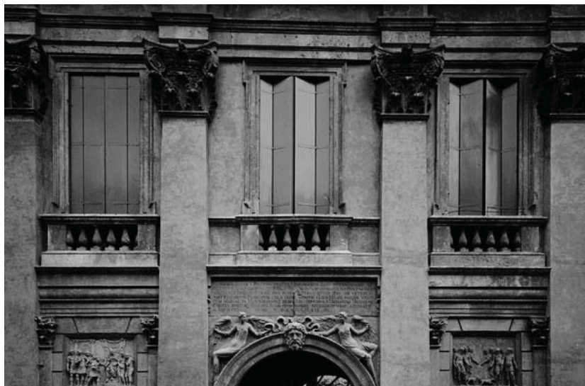
Figuur 6. De hiërarchische orde van de verdiepingen wordt door de doorgetrokken compositezoulen doorbroken in Palazzo Valmarana
