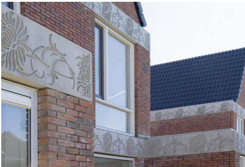
Figuur 68. Een gedetailleerd stuk van de gevel met de samenkomst van baksteen en beton.
