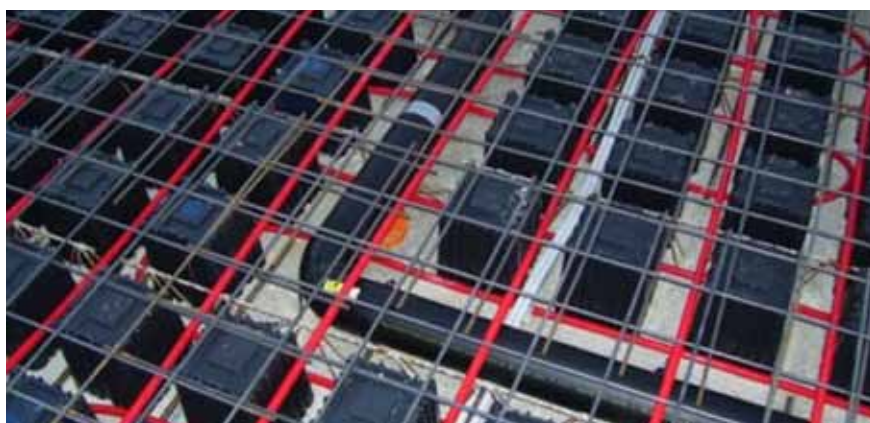
-Figuur 2- TABS layout (rood) en luchtdozen (zwart) verankerd op de betonnen plaat
