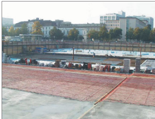
Abb. 2: Montage des Bodenplattenabsorbers
