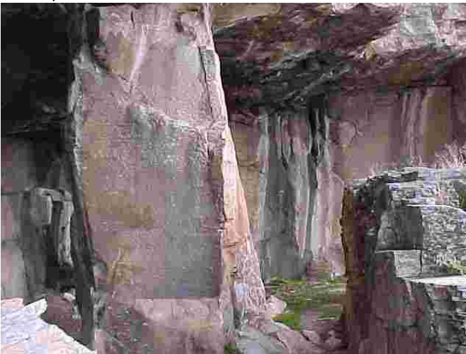
Abbildung 216: Stützpfeiler im Untertageabbau von Kuşini
