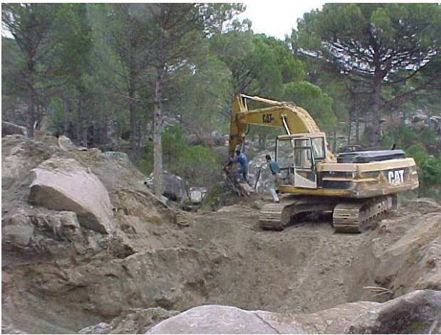
Abbildung 304: Abtransport von Granodioritblöcken
