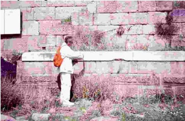
Abbildung 312: Marmorleiste in Andesitmauer
