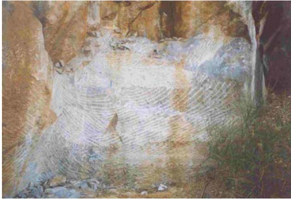
Abbildung 127: Manuell erzeugte Schrämspuren an Lesbos-Moria-Abbauwand
