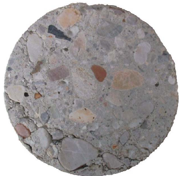
Abbildung 68: Rissbild eines Ermüdungsbeanspruchten Betons
