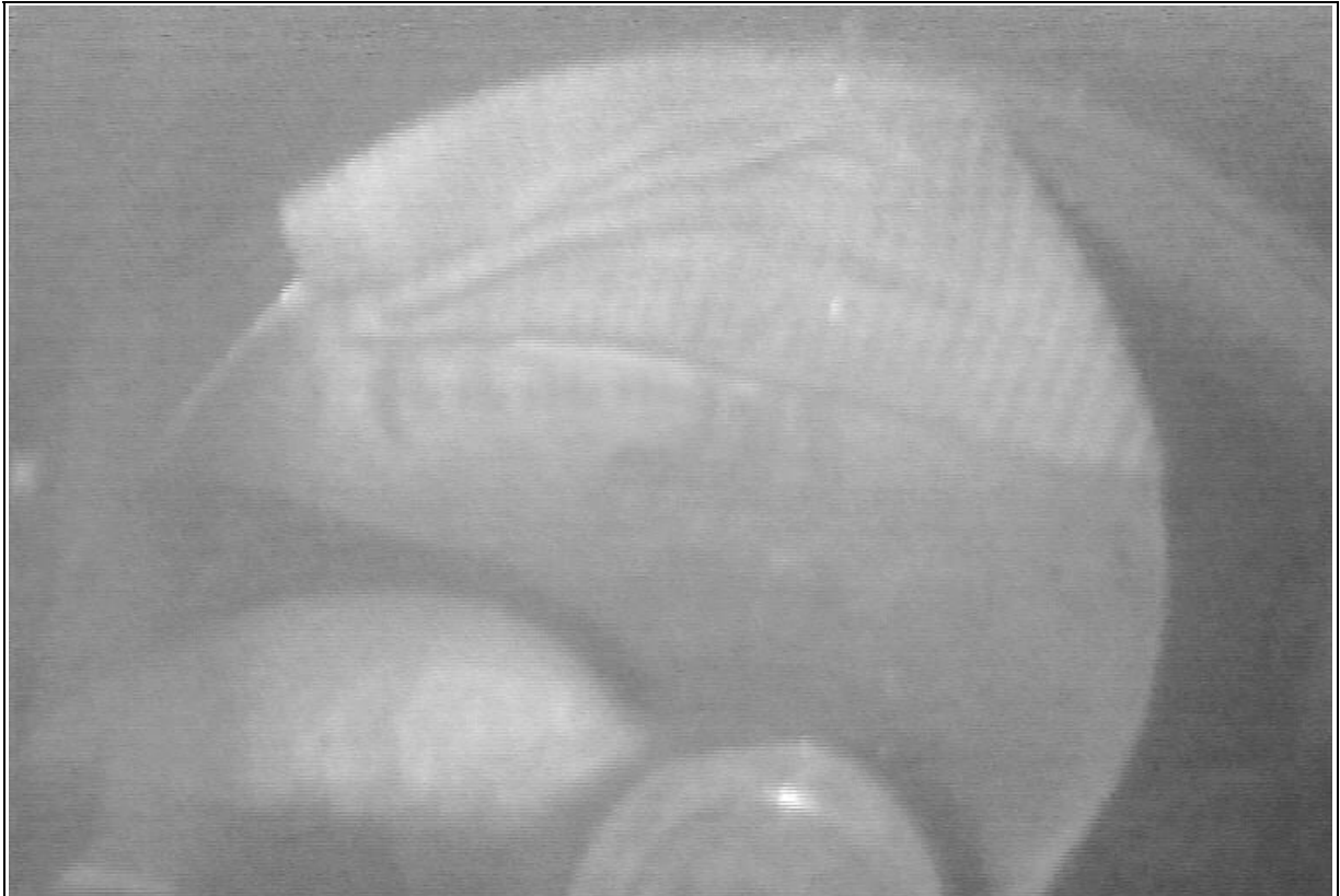
Bild 50. Fotografische Darstellung des Laufrads mit einer Verschmutzung durch einen Stofflappen
