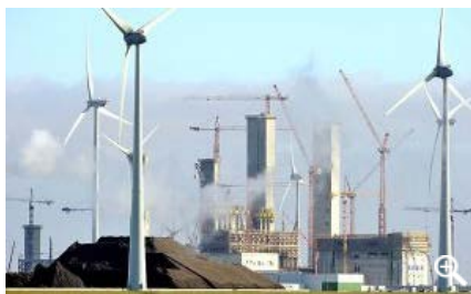
Kolencentrale in aanbouw in de Groningse Eemshaven. Foto ANP
