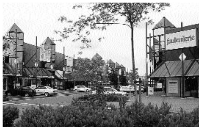
Afbeelding 6.6 Eenheid in vormgeving door buizenconstructie en pundaken. Woonboulevard Heerlen. Foto: Henk van der Veen, 1998.
