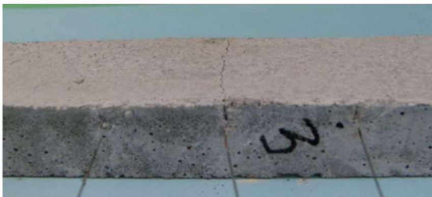
Figura 28 - Amostra indicando a fissura e os fios de ferro através da mesma (Pelletier et al., 2011)
