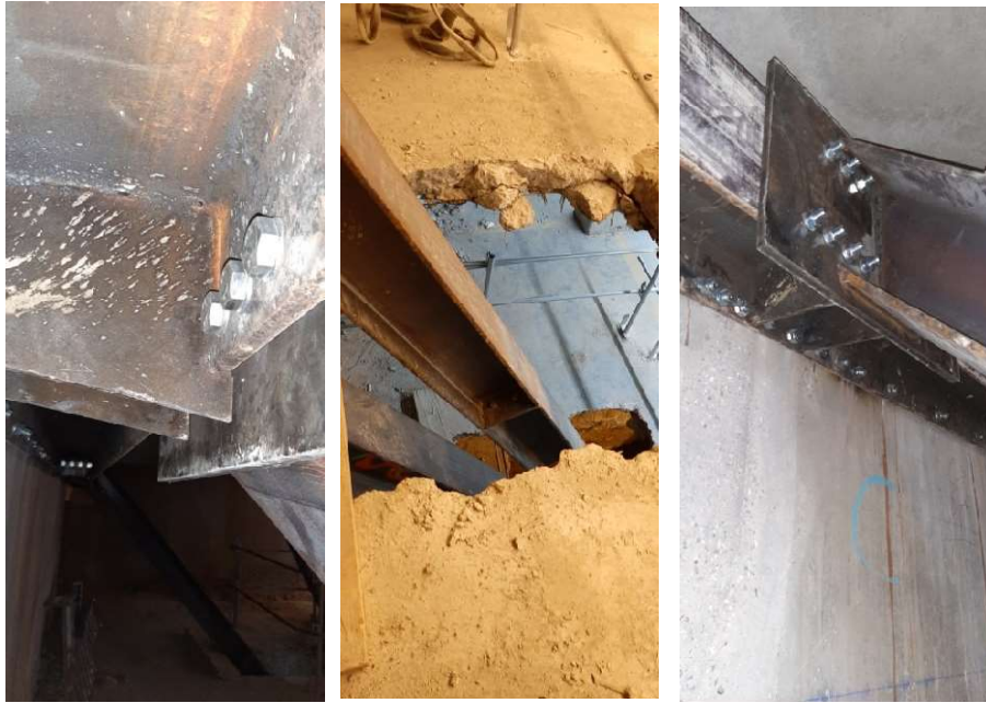
Figura 52: Execução das conexões metálicas de fundação
