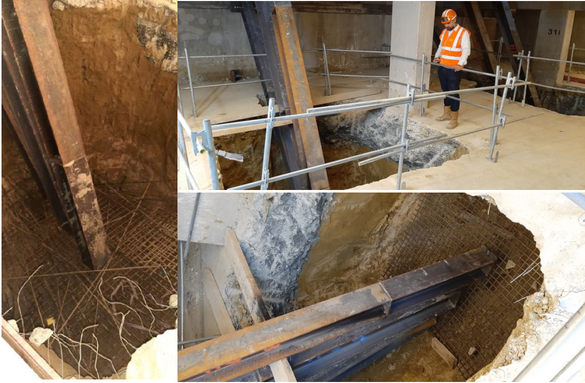
Figura 51: Execução dos blocos
