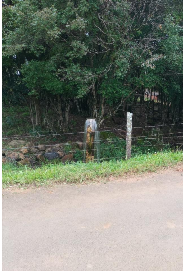
Figura 27 – Tubulação de saída do barramento existente no Ponto 2.
