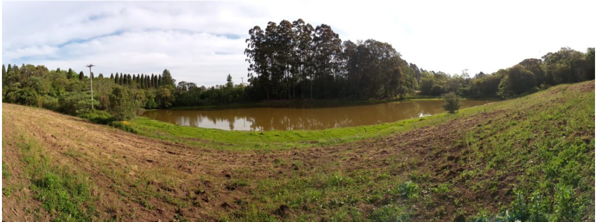
Figura 41 – Foto panorâmica da nascente e reservatório do Ponto 8.
